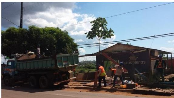
**Figura 12.1.3 - 9 – Demolição de moradia de madeira, material encaminhado à Cerâmica Santa Clara - Data: 07/07/2014**
