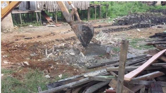
**Figura 12.1.3 - 17 – Preenchimento de poço
