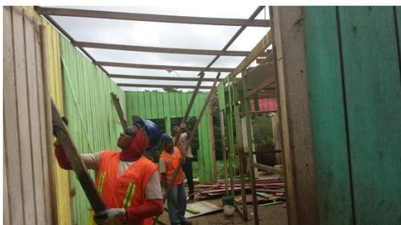
**Figura 12.1.3 - 7 – Demolição, retirada cuidadosa da madeira. Data: 01/07/2014**
