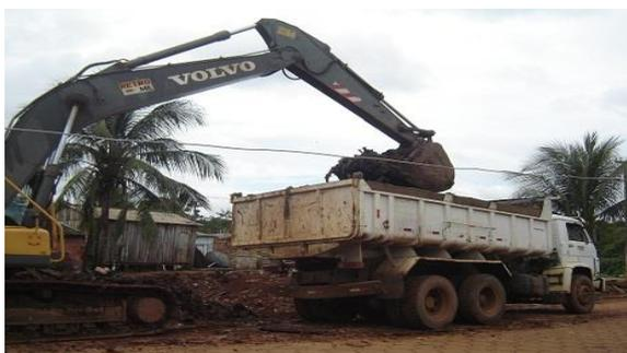
**Figura 12.1.3 - 43 – Serviços de limpeza e retirada de material. Data: 13/01/2015**
