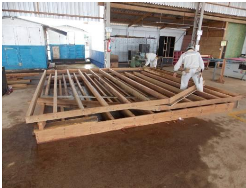
Figura 12.1.2 - 10 – Uso interno - Carpintaria / Unidade Pimental - Coordenada UTM: Zona 22 M 400152/9620746.
