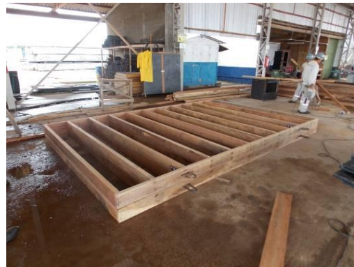
Figura 12.1.2 - 11 – Uso interno - Carpintaria / Unidade Pimental - Coordenada UTM: Zona 22 M 400152/9620746.
