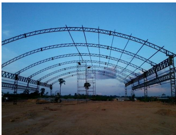
Figura 12.1.2 – 21 – Serraria Ipê – Implantação do Barracão
