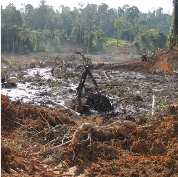
**Figura 12.1.1 - 24 – Retirada do resíduo com uso de escavadeira hidráulica adaptada com pinça em área alagada.**
