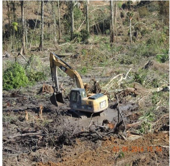
**Figura 12.1.1 - 17 – Escavadeira hidráulica realizando bosqueamento em área alagada.**
