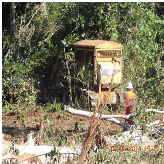
**Figura 12.1.1 - 13 – Trator esteira realizando bosqueamento.**
