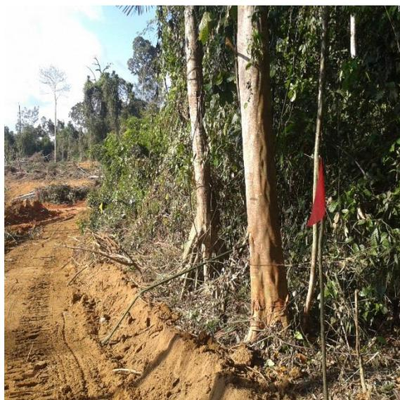
**Figura 12.1.1 - 11 – Demarcação de NA com bandeirolas após levantamento topográfico.**
