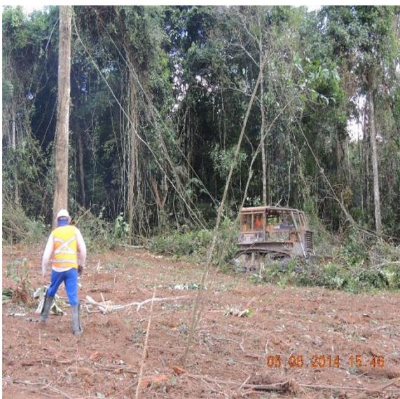
**Figura 12.1.1 - 14 – Trator esteira realizando bosqueamento.**
