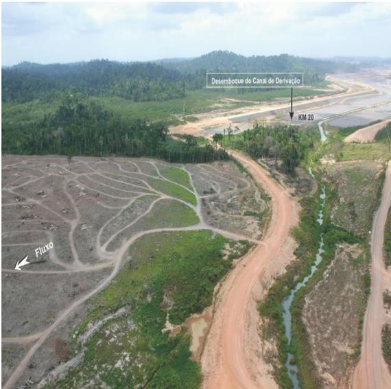
**Figura 12.1.1 - 79 – Supressão na região do Canal de Derivação e Reservatório Intermediário.**
