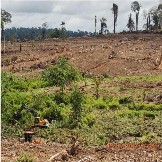
**Figura 12.1.1 - 16 – Escavadeira hidráulica realizando bosqueamento em área alagada.**
