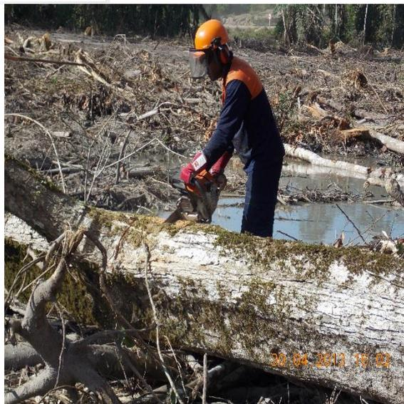
Figura 12.1.1 - 37 – Destopa com uso de motosserra
