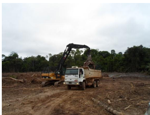
Figura – 12.1.1 - 15 – Realização de atividade de limpeza de resíduos, Unidade Belo Monte - Coordenada UTM: Zona 22 M 410188 / 9648869
