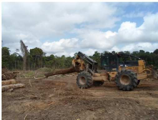
Figura – 12.1.1 - 12 – Transporte de toras para área de esplanada, Unidade Belo Monte - Coordenadas em UTM 22M: 410081 / 9648815
