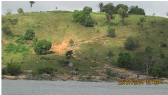
Inspeção Trimestral 10 (julho/2014 - cheia): Área potencialmente estável. Nota-se leve diminuição da vegetação na encosta e maior exposição das rochas próximas à margem do rio Xingu, devido ao rebaixamento de seu nível.
