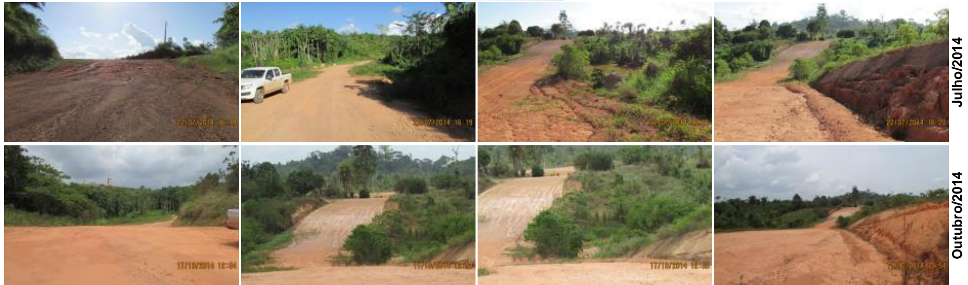
Figura 10.3 - 3 – Situação da área ilustrada na Figura 10.3 - 2, nas inspeções realizadas em julho e outubro de 2014.
