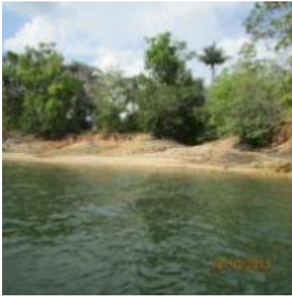
Inspeção Trimestral 7 (outubro/2013 - seca): Aumento da zona de praia devido à redução de nível do rio Xingu. Igualmente aos casos comentados anteriormente, sem mudanças perceptíveis do risco geotécnico original.
