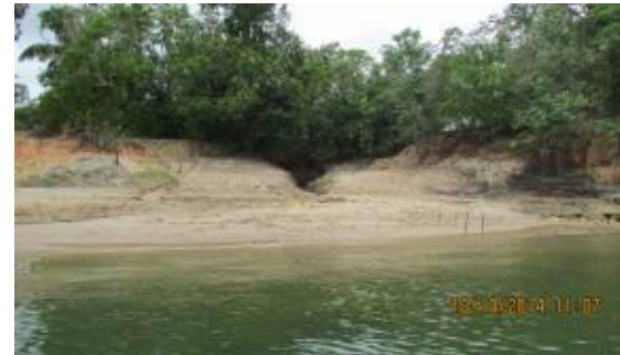
Inspeção Trimestral 11 (outubro/2014 - seca): Área aparentemente estável. Devido ao rebaixamento do nível do rio, observa-se maior exposição do talude em relação à vistoria anterior. Novamente, pouca diferenciação de características em relação às visitas anteriores em épocas similares.
