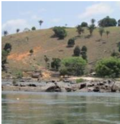
Inspeção Trimestral 7 (outubro/2013 - seca): Área potencialmente estável. Maior exposição das rochas próximas à margem do rio Xingu, devido à redução de seu nível.
