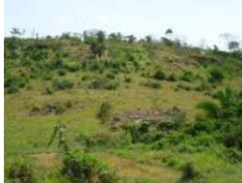
Inspeção Trimestral 2 (agosto/2012 - vazante): há a perceptível mudança na cobertura vegetal nos casos comparados, sem haver, no entanto, qualquer mudança de origem geotécnica, ou seja, o aparecimento de processos relacionados à erosão e o rolamento de blocos na encosta.
