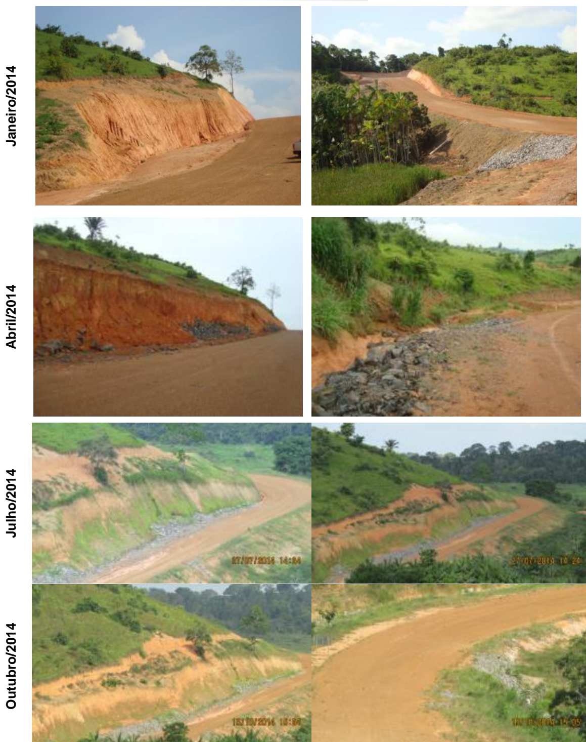
Figura 10.3 - 6 – Ilustrações do ponto cadastrado para monitoramento – CS25 (Travessão 45).
