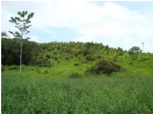
Inspeção Trimestral 4 (fevereiro/2013 - enchente): Encosta vegetada, com matacões residuais de rocha cristalina, porém estável.
