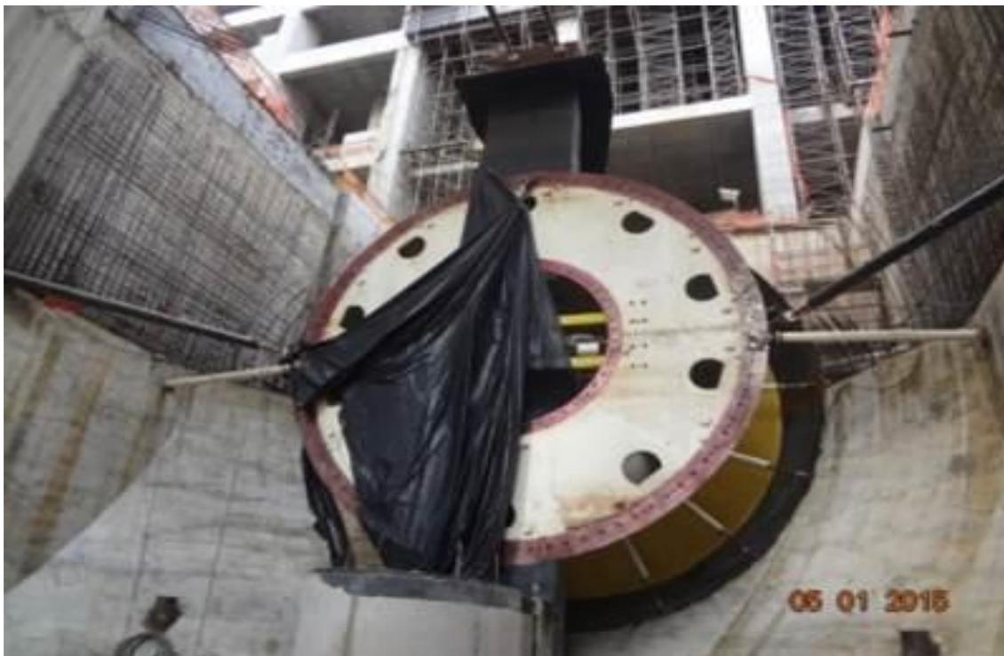
**Figura 1 – 34 - Sítio Pimental – Montagem do Stay Column e Stay Cone da CF-01**
