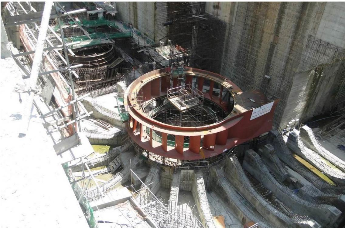
**Figura 1 – 33 - Sitio Belo Monte – Atividades de Montagem do Pré-Distribuidor da CF-03**
