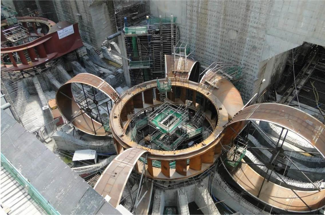
**Figura 1 – 32 - Sitio Belo Monte – Montagem da Caixa Espiral da CF-02**
