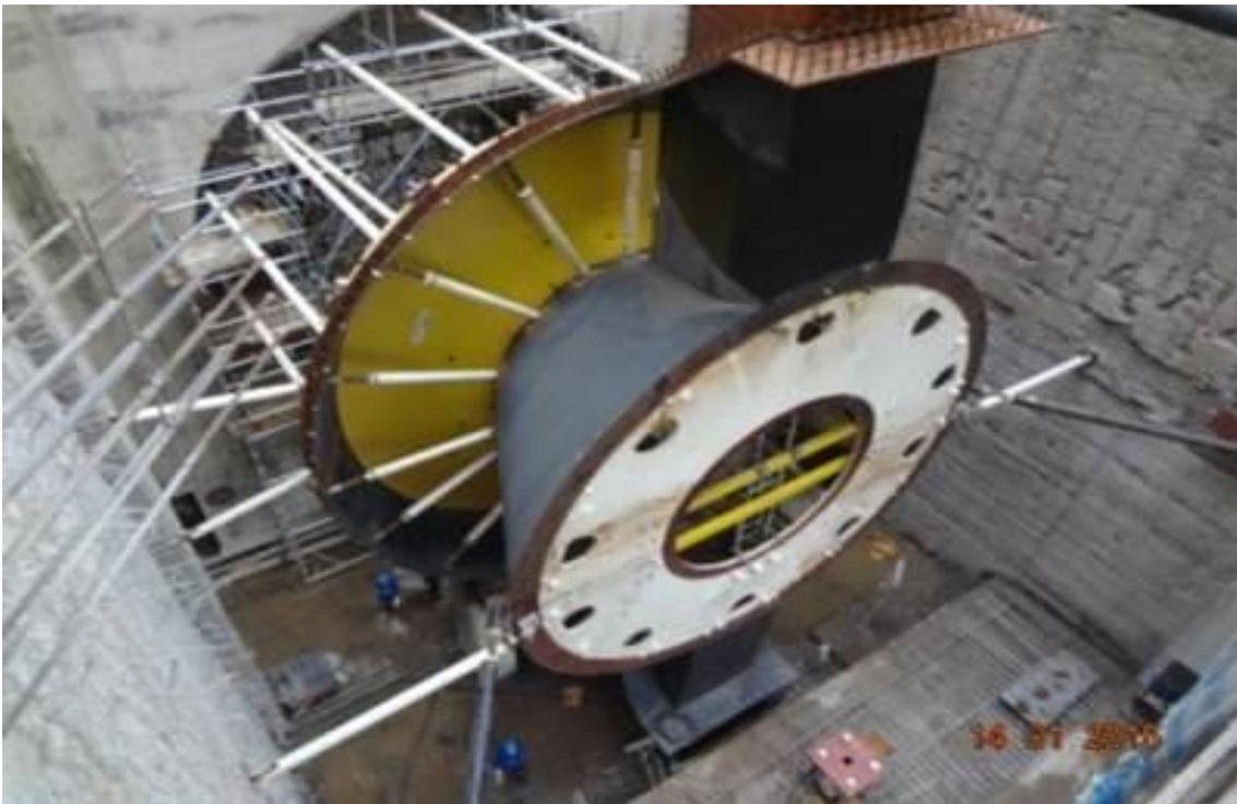
**Figura 1 – 36 - Sitio Pimental – Montagem do Stay Column e Stay Cone da CF-02**
