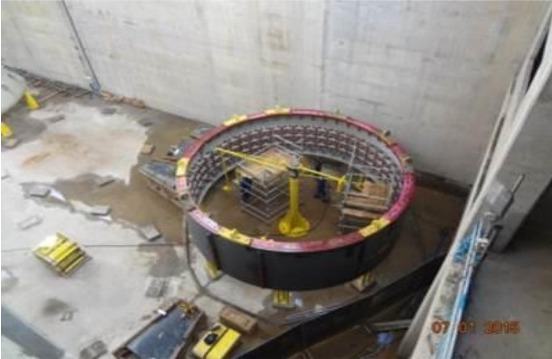
**Figura 1 – 35 - Sitio Pimental – Pré-Montagem da Carcaça do Estator da CF-01**
