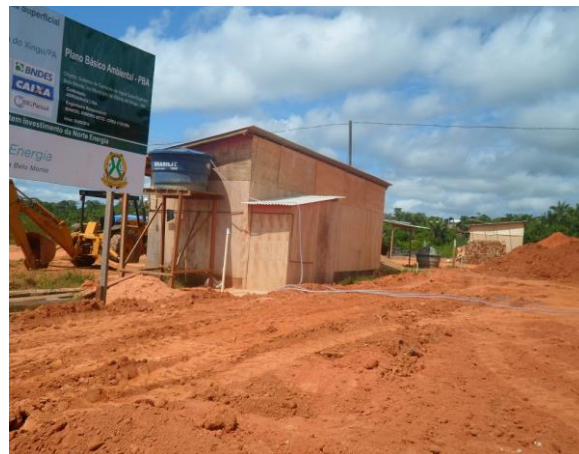
Figura 5.3.19 - 5 – Barracão da obra, placa da obra e terraplenagem do terreno com locação para implantação da ETA.
