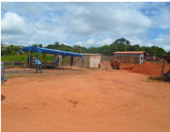
Figura 5.3.19 - 4 – Dobra de ferragem para concretagem das estruturas da ETA.
