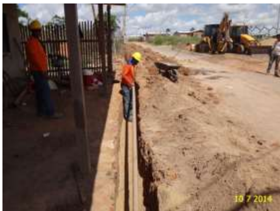
Figura 5.2.19 - 1 – Abertura de valas e instalação de tubulação para ampliação da rede.
