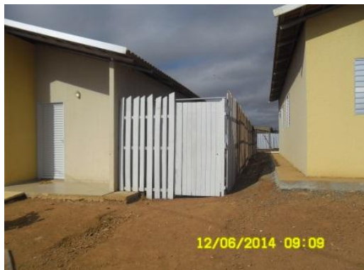
Figura 4.4.3 - 33 - Utilização da madeira na construção de cerca do lote
