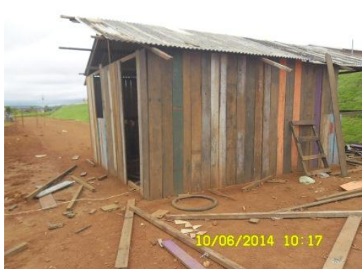
Figura 4.4.3 - 31 - Construção de moradia no fundo do quintal
