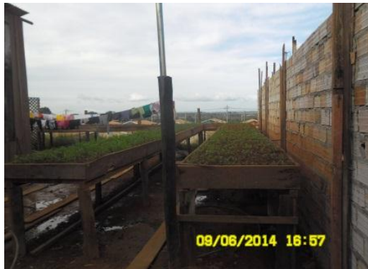
Figura 4.4.3 - 28 - Utilização da madeira na construção de canteiro suspenso
