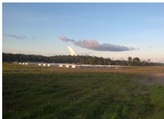
Figura 3.2 - 32 - Área após plantio e estaqueamento, no BF-36B – Unidade Canais e Diques.
