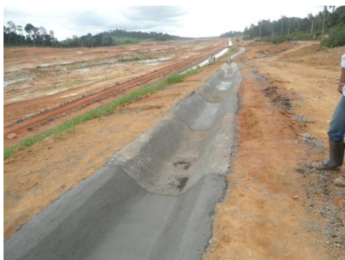
Figura 3.2 – 7 - Canaleta de drenagem ao longo do canal de derivação, Unidade Canais e Diques.
