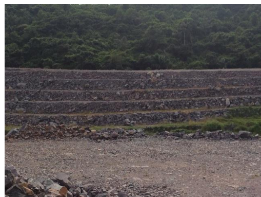
Figura 3.2 – 12 - Implantação de enrocamento de proteção no BF-10, Unidade Canais e Diques.
