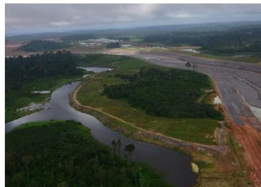
Figura 3.2 - 23 - Vista aérea da área do BF-18 após o plantio (junho/2014), Unidade Canais e Diques.
