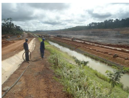
Figura 3.2 – 13 - Atividade de aplicação de fertilizante nas áreas hidrossemeadas ao longo do Canal de Derivação, Sítio Canais e Diques.
