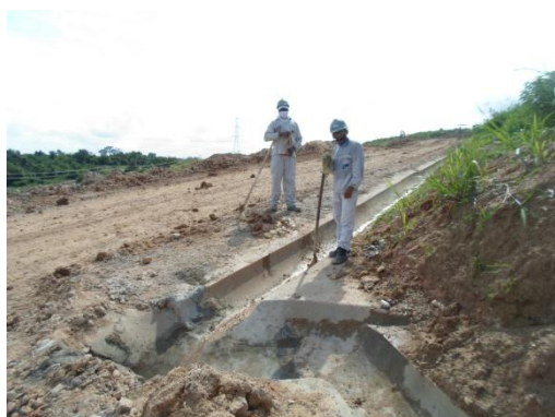
Figura 3.2 – 1 - Manutenção do sistema de drenagem, limpeza de canaletas, BF-03/06, Unidade Belo Monte.
