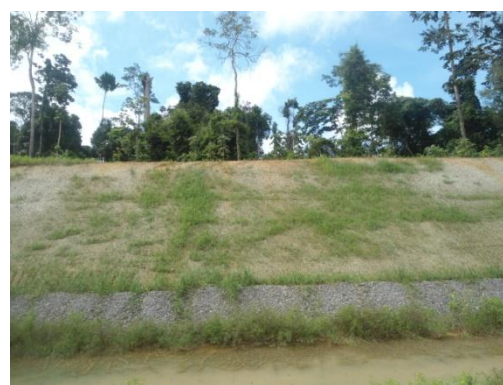
Figura 3.2 – 14 - Vista Geral após a realização da atividade de repasse de hidrossemeadura, km 4,5 MD, Unidade Canais e Diques.
