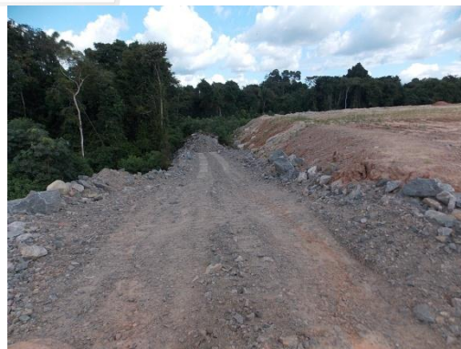
Figura 3.2 – 10 - Implantação de enrocamento de talude, Bota Fora IPJ, Unidade Pimental.
