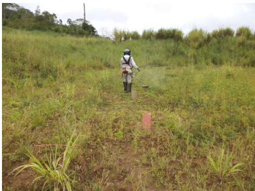
Figura 3.2 – 29 - Execução da atividade de roçada (limpeza) no BF-36B – Unidade Canais e Diques.
