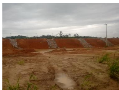
Figura 3.2 – 2 - Descida d'água e bacia de sedimentação Dique 13 – Canteiro Bela Vista, Unidade Canais e Diques.
