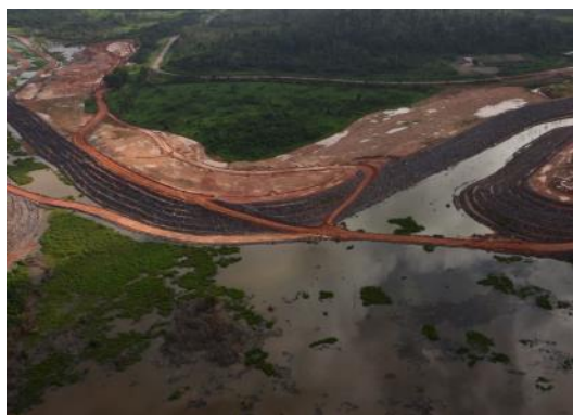
Figura 3.2 – 11 - Implantação de enrocamento no sistema de drenagem do BF-33, Unidade Canais e Diques.
