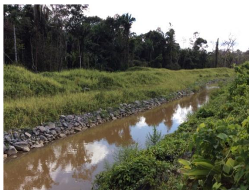
Figura 3.2 – 16 - Vista parcial da Vala Xingu revegetada por meio de hidrossemeadura, Unidade Canais e Diques.
