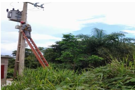
**Figura 3.1 - 5 – Manutenção de transformadores – Belo Monte.**
