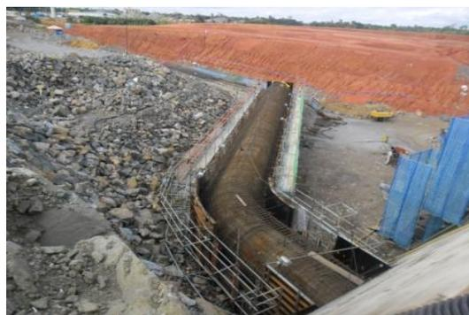
**Figura 3.1 - 4 – Construção do Sistema de Transposição de Peixes – Sítio Pimental.**
