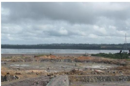
**Figura 3.1 - 3 – Escavação e transporte de solo e rocha no canal de fuga – Sítio Belo Monte**
