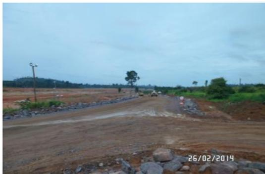
**Figura 3.1 - 1 – Abertura de desvio da via Leste-Oeste no km 16 – Sítio Canais.**
