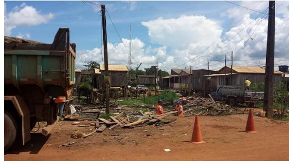
**Figura 12.1.3 - 24 – Retirada de madeira proveniente da demolição. Data: 19/05/2014**
