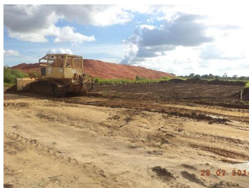
**Figura 12.1.3 - 6 – Preparação do local definitivo para o depósito dos resíduos no Aterro Sanitário. Data: 28/02/2014**
