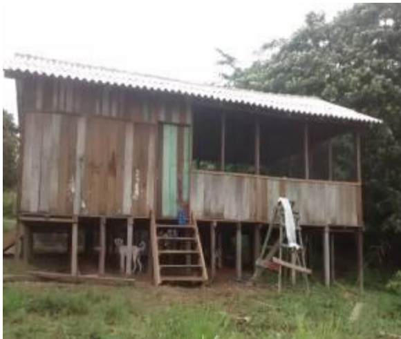
Figura 7.2 - 62: Galpão de secagem e armazenamento da castanha na aldeia Curuá. Em:13.05.2015.
