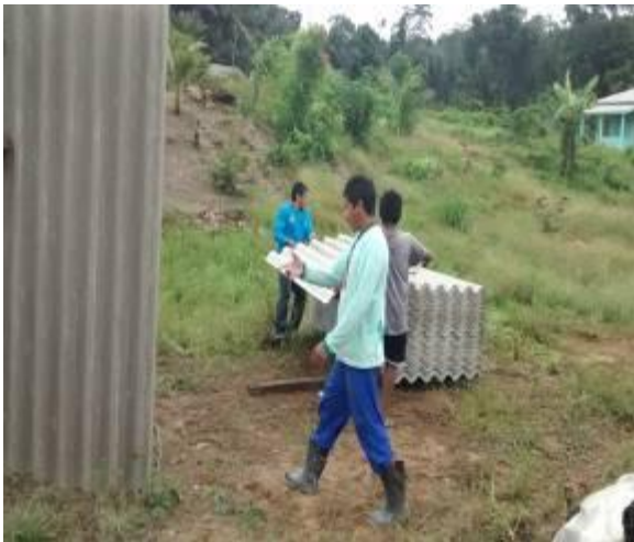
Figura 7.2 – 59 - Entrega do material para construção do galpão – TI Kuruaya (Aldeia Curuatxe). Em: 05.02.2015.
