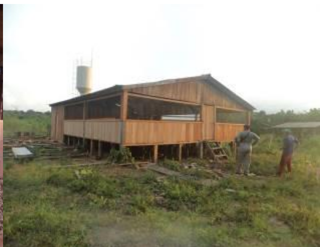
Figura 7.2 – 69- Galpão de castanha – TI Xipaya (Aldeia Tukayá). Em: 06.02.2015.
