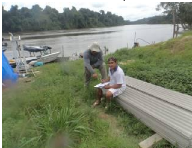
Figura 7.2 – 61 - Entrega dos materiais para construção do galpão de castanha – TI Kuruaya. Em: 05.03.2015.
