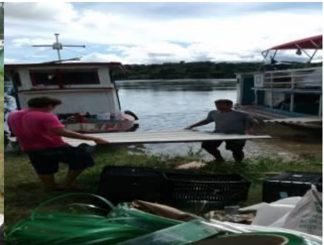
Figura 7.2 – 60 - Entrega do material para construção do galpão – TI Kuruaya (Aldeia Curuá). Em: 06.02.2015.
