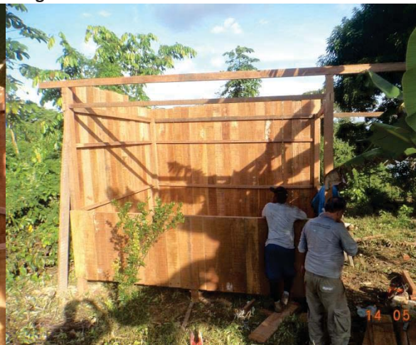
Imagem 8: Construção das Laterais Fechadas.
