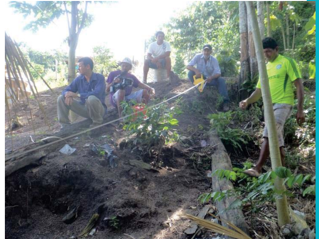
Imagem8: Demarcação dos Aviários, Data 27/04/2015.
