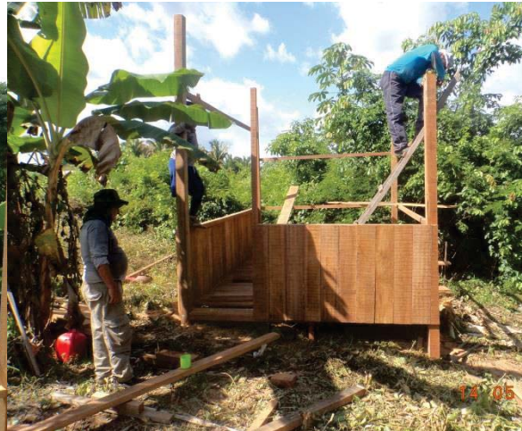
Imagem 6: Detalhe da Lateral Telada.
