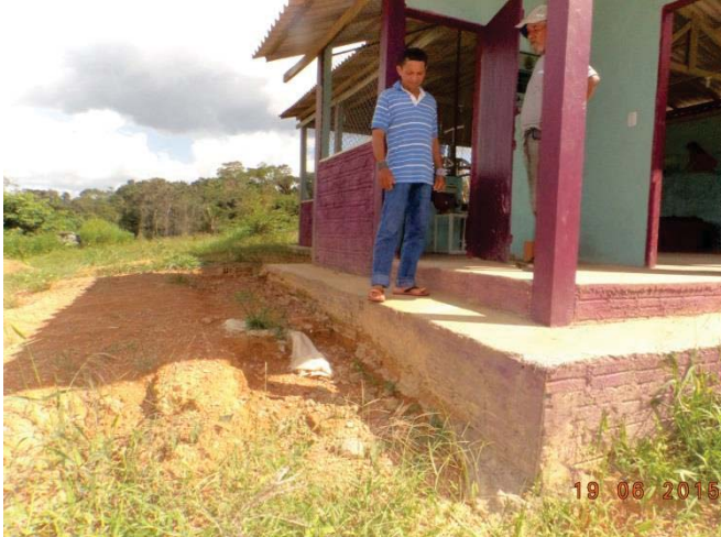
Imagem 13: Detalhe da erosão na lateral da Casa de Farinha da Adeia Furo Seco.
