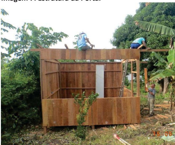
Imagem 9: Construção da Armação do Telhado.
