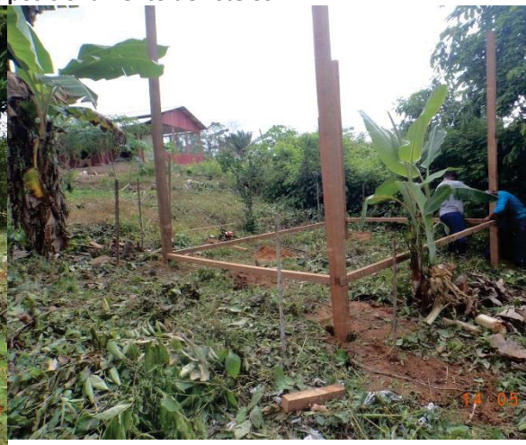
Imagem 4: Estrutura da Construção.
