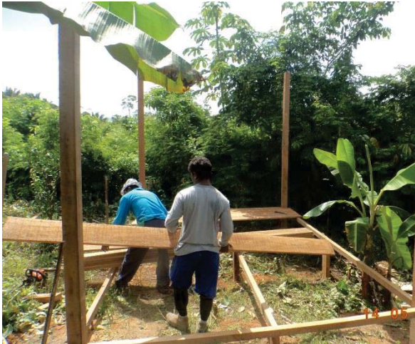
Imagem 5: Construção do Assoalho.
