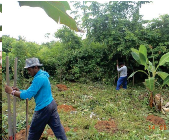
Imagem 2: Perfuração Manual de buracos para posicionamento de Esteios.
