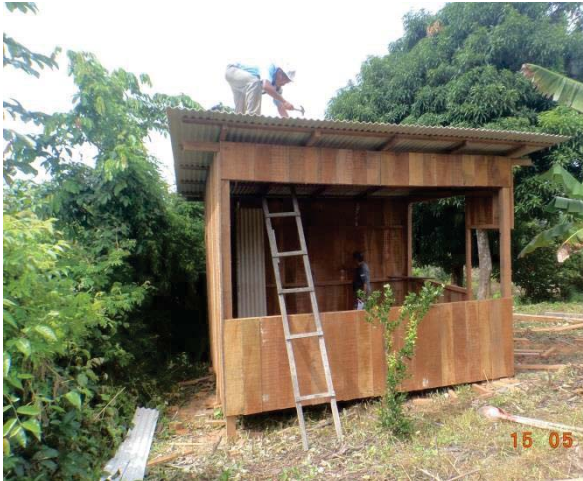
Imagem 11: Finalização do Telhado.
