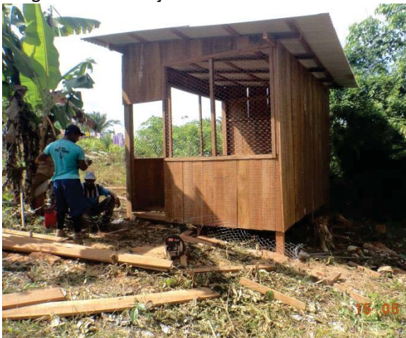
Imagem 13: Lateral telada, Fachada.
