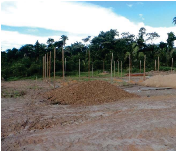
Figura 13: Início da Construção da Casa de Farinha – Aldeia Itaaka (26/03/2015)
