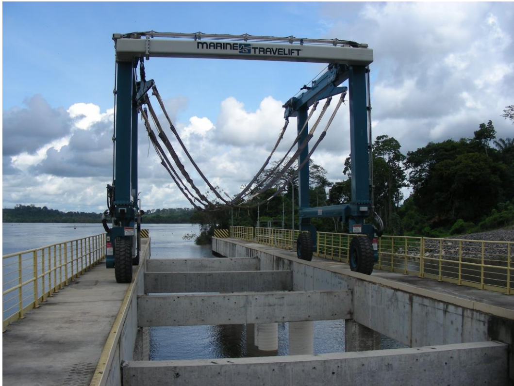
Fotografia 4 – Estrutura jusante para transposição por Travel Lift
