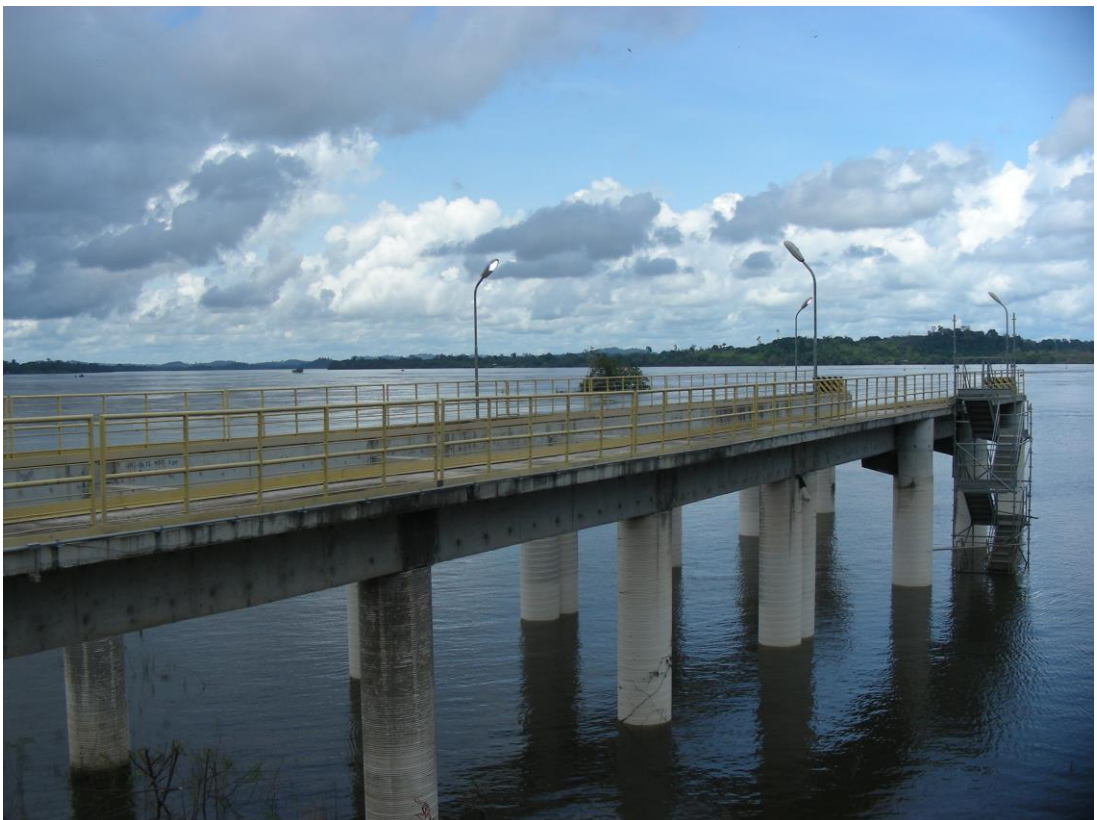
Fotografia 3 – Estrutura jusante para transposição por Travel Lift
