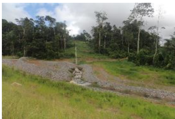
Figura 14.4-18 – Canal de drenagem em formato de cascata que serve para desviar o igarapé Cajueiro (23/04/2015).
