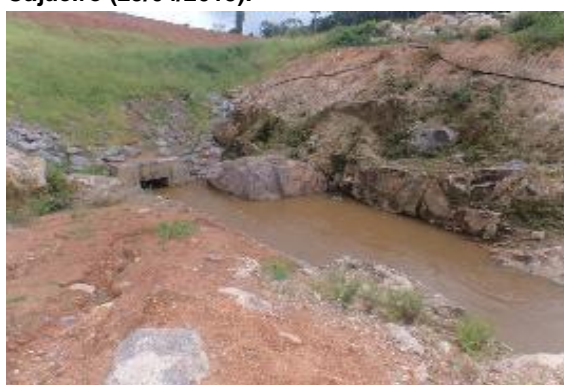
Figura 14.4-20 – Galeria de drenagem para garantir o percurso normal do igarapé Cobal, interceptado pelo dique 13 (23/04/2015).
