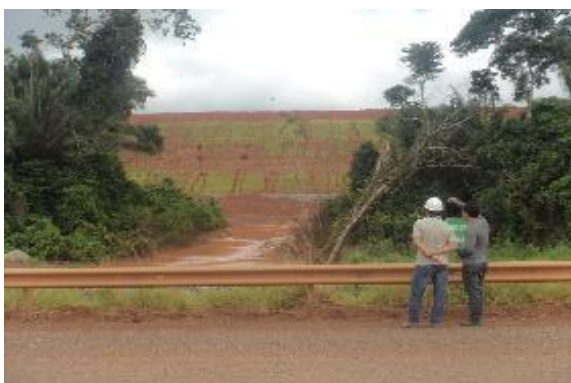
Figura 14.4-17 – Visita técnica ao dique 14 que intercepta o igarapé Cajueiro (23/04/2015).
