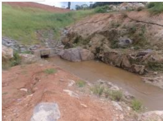
Figura 14.1 – 8 – Galeria de drenagem para garantir o percurso normal do igarapé Cobal.
