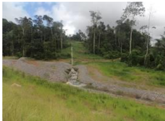
Figura 14.1 - 6 - Canal de drenagem em formato de cascata do dique 14.
