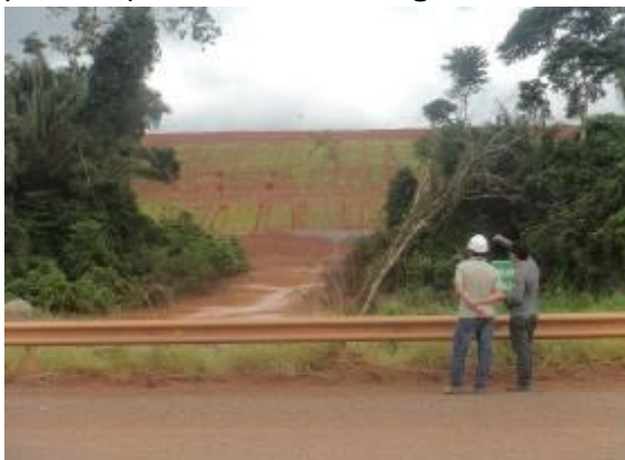
Figura 14.1 - 5 - Visita técnica ao dique que intercepta o igarapé Cajueiro.
