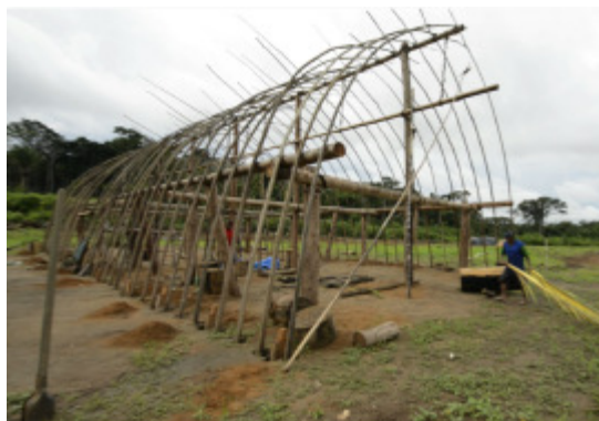
Figura 11.2- 26: Tavyva já com a estrutura montada, aldeia Ita-aka, 19/02/2015.
