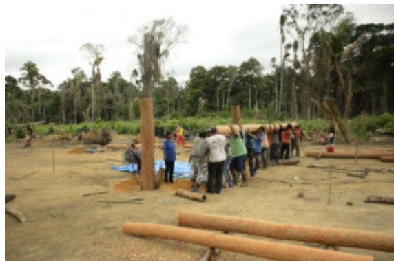
Figura 11.2- 25: Primeira etapa de construção da Tavyva na aldeia Ita-aka, 15/01/2015.
