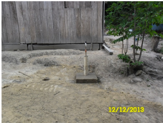
Figura - 1 – Ramal domiciliar instalado
