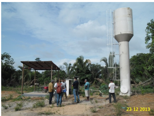
Figura - 5 – Vista geral do sistema em destaque o reservatório de 10 m 3 instalado.
