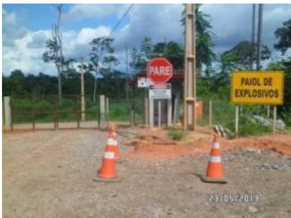
Figura - 1 – Entrada do paiol de explosivos
