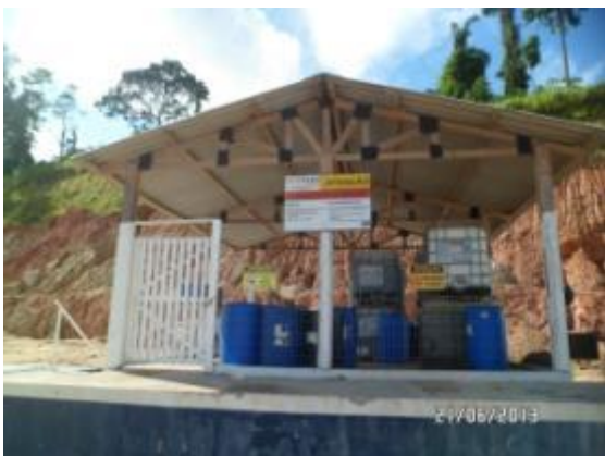
Figura - 11 - Depósito de produtos químicos
