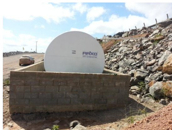
Figura - 2 – Depósito de óleo lubrificante usado
