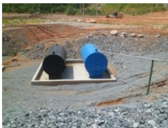
Figura - 6 – Depósito de óleo lubrificante usado
