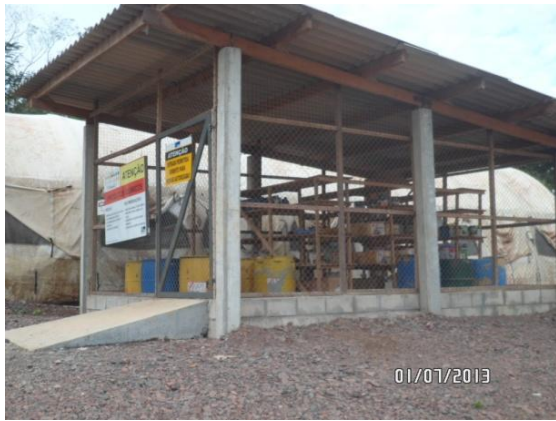
Figura - 9 - Depósito de produtos químicos
