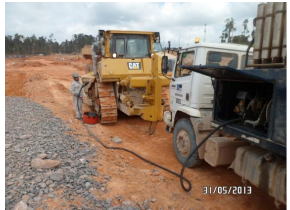
Figura - 10 – Abastecimento dos equipamentos em campo
