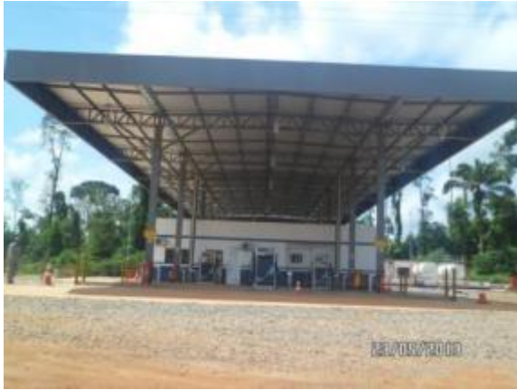
Figura - 7 – Plant definitivo em processo de instalação – Sítio Pimental
