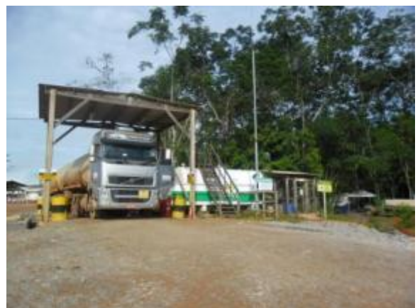
Figura - 6 – Plant provisório – Sítio Pimental
