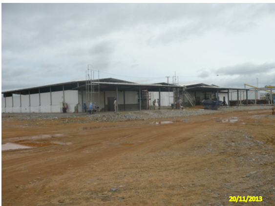
Figura - 7 – Construção do refeitório da Ilha Marciana – Sítio Pimental
