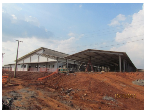
Figura - 11 – Refeitório lado Sul (vista externa) – Sítio Belo Monte
