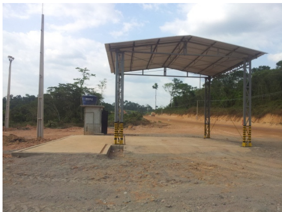
Figura - 1 – Construção do Plant de abastecimento – Sítio Bela Vista
