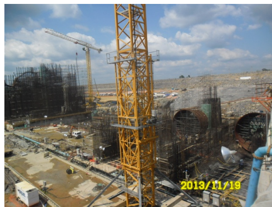
Figura - 8 – Viloras instalas e levantamento dos pilares do vertedouro canteiro de Pimental.
