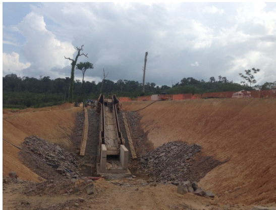
Figura - 4 – Concretagem do vertedouro na bacia 14 – Sítio Canais e Diques
