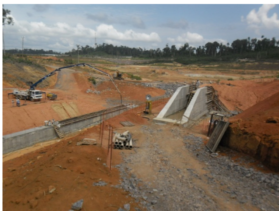
Figura - 9 – Vertedouro da Bacia 15, Montante – Sítio Canais e Diques
