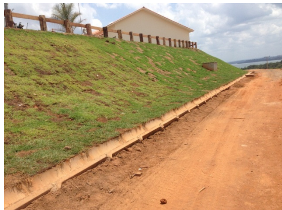
Figura - 3 – Sistema de drenagem e proteção de talude – revestimento com placa de grama – Sítio Belo Monte
