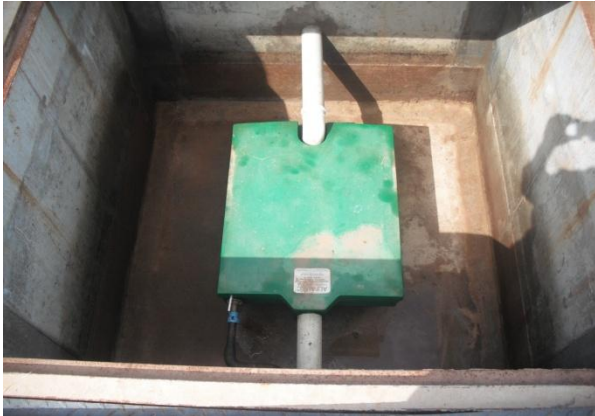
Figura - 9 – Caixa SAO plant definitivo
