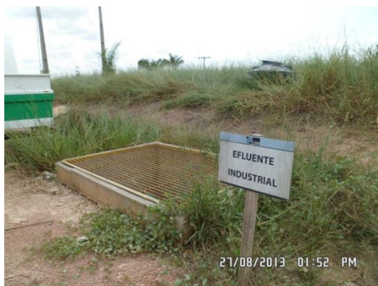
Figura - 5 – Caixa SAO do plant de combustível II do Sítio Belo Monte
