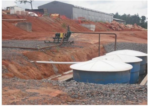
Figura - 8 – Sistema de reutilização da água da rampa de lavagem da Oficina Mecânica
