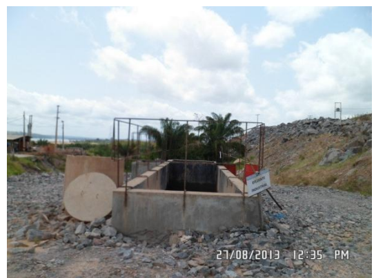
Figura - 6 – Caixas SAO da Rampa de lavagem/oficina mecânica definitiva do Sítio Belo Monte
