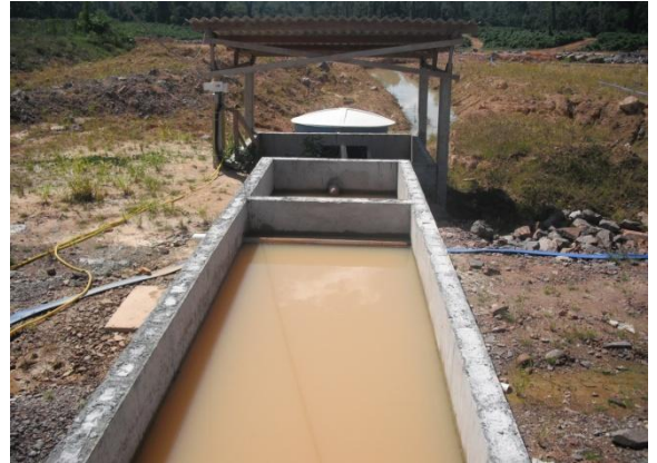
Figura - 8 – Sistema de reutilização da água da rampa de lavagem da Oficina Mecânica
