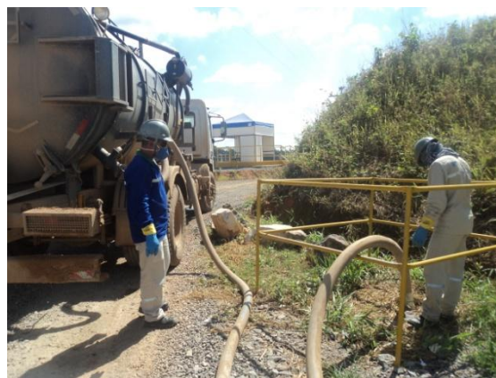
Figura - 4 - Coleta de efluentes da fossa localizada no Britador.
