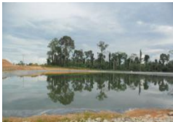
Figura - 9 - Lagoa facultativa para tratamento de efluentes do sitio Pimental.
