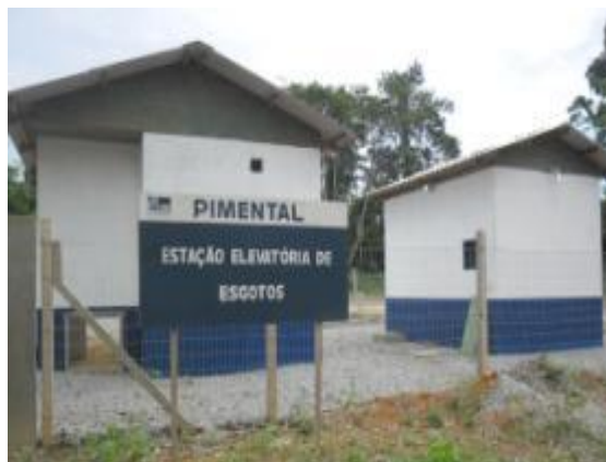
Figura - 6 - Estação elevatória de esgoto do canteiro de Pimental.
