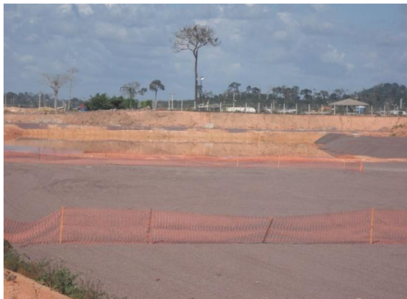
Figura - 2 - Área de construção do sistema de pós-tratamento das lagoas (Wetland);
