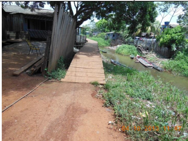
Foto 49 - Via da passarela principal em bom estado de conservação
