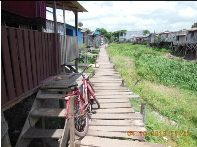
Foto 35 - Ramal 01 - Passarela principal com estrutura boa
