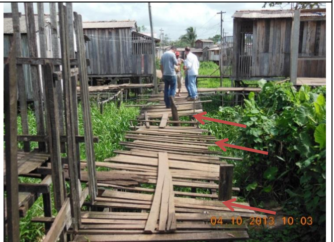
Foto 58 – Estrutura e pista comprometida.
