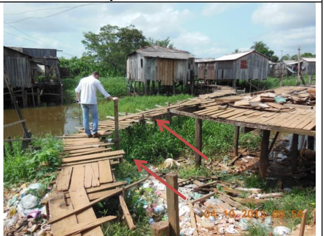
Foto 58 – Estrutura e pista comprometida.
