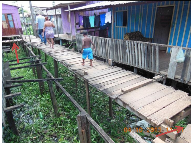
Foto 47 - Bom estado de conservação
