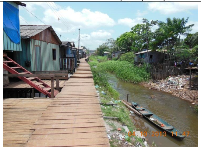
Foto 50 - Passarela principal em bom estado de conservação em toda a sua extensão.
