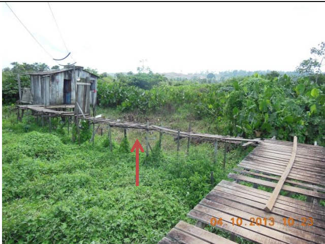
Foto 31 – Casas sem acesso.
