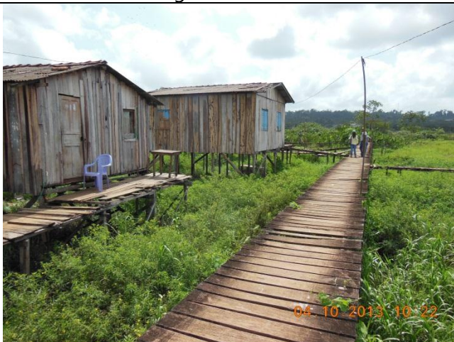
Foto 27 – Passarela principal em bom estado.
