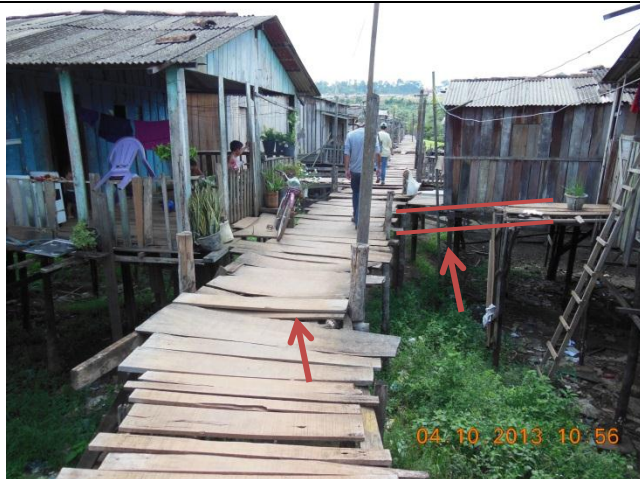
Foto 03 - Estrutura em estado razoável de conservação.
