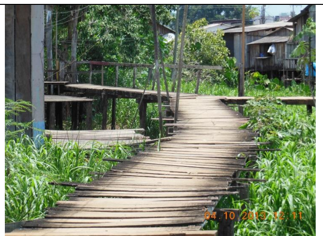
Foto 54 - Estrutura da via principal em bom estado
