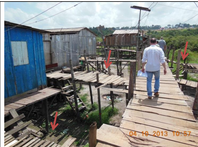
Foto 05 - Estrutura em estado razoável de conservação.
