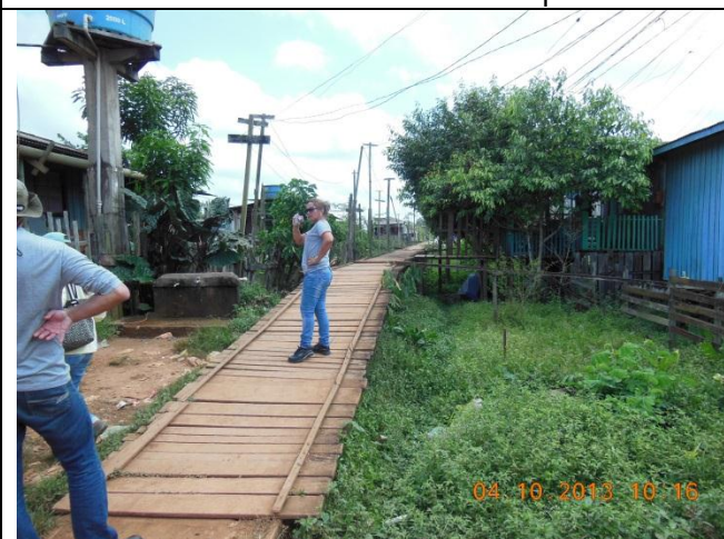
Foto 21 - A passarela principal está em bom estado.
