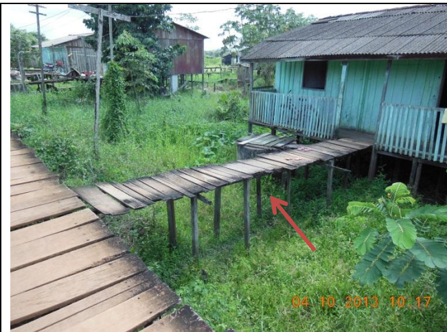
Foto 29 – Acessos estreitos às residências
