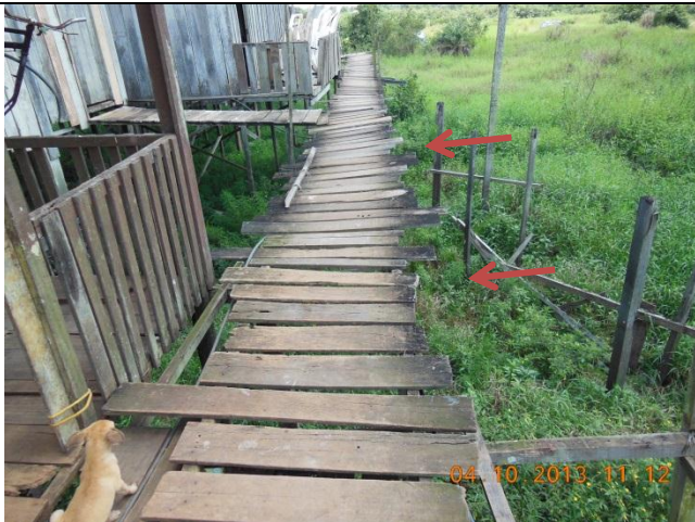
Foto 13 - Parte final da passarela principal..
