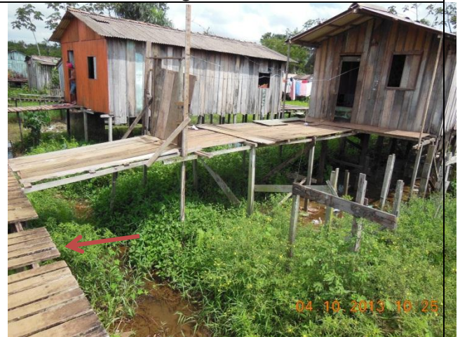
Foto 32 – Acesso em bom estado.
