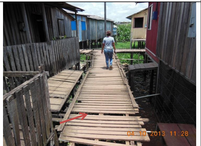
Foto 38 - Estrutura em bom estado, sendo necessários pequenos reparos na pista.
