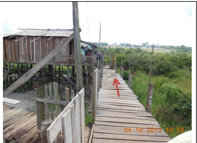
Foto 06 - Trecho do acesso principal bom.
