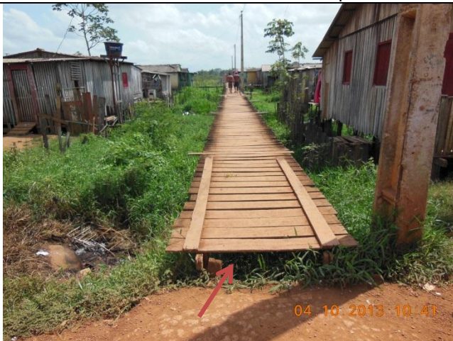
Foto 15 - Acesso principal em bom estado de conservação.
