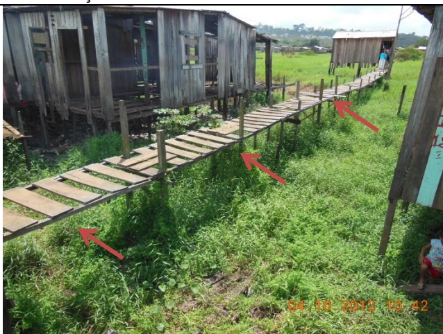
Foto 17 – Passarela lateral com estrutura em bom estado.
