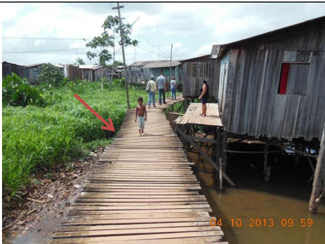
Foto 57 – Falta de rampa de acesso, mas sem escoramento
