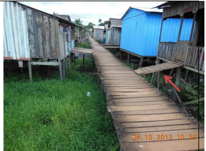
Foto 24 – Pista e estrutura em bom estado.
