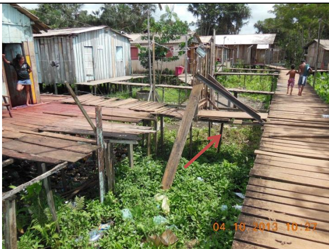
Foto 33 - Acessos em estado regular.
