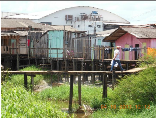
Foto 55 - Ramais necessitam de reparos.
