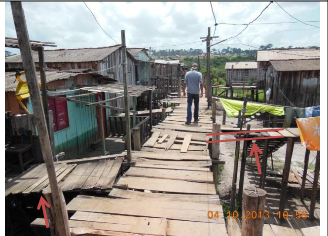
Foto 04 - Estrutura em estado razoável de conservação.
