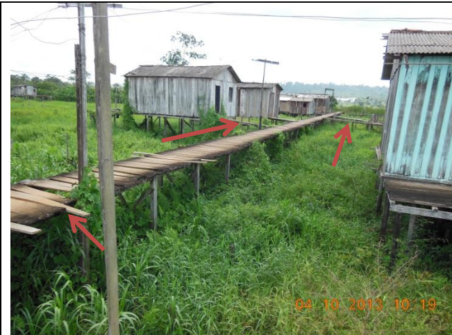
Foto 23 – Pista e nos acessos as casas.
