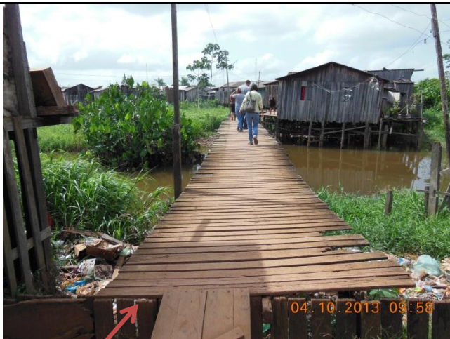
Foto 57 – Falta de rampa de acesso, mas sem escoramento
