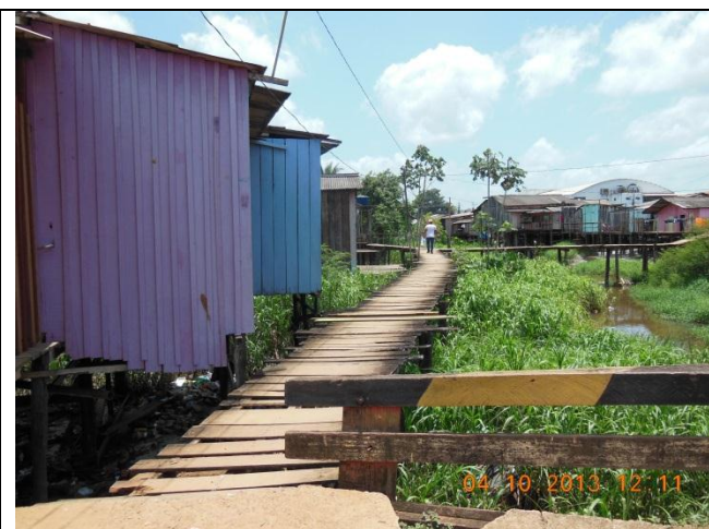
Foto 53 - Estrutura da via principal em bom estado
