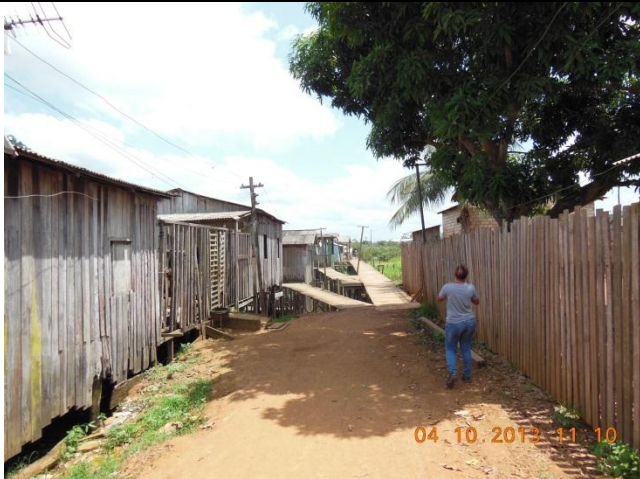
Foto 11 - Estrutura da pista principal em bom estado..
