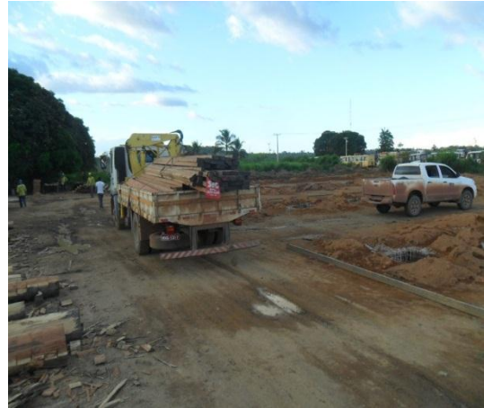
Figura – 12.2. 14 – Produtos Florestais usados na construção do barracão da base de apoio IBAMA – Uso Interno.
