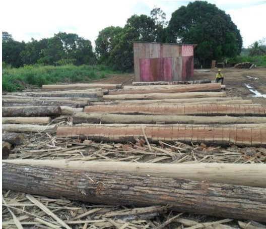
Figura – 12.2. 13 – Mourões utilizados na construção do barracão da base de apoio IBAMA- Uso Interno.
