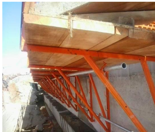
Figura - 12.2. 12 – Construção de estruturas a partir do produto florestal, proveniente da atividade de supressão vegetal, coordenada UTM Zona 22 M 395870 / 9619662
