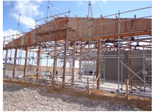
Figura – 12.2. 8 – Construção de estruturas a partir do produto florestal, proveniente da atividade de supressão vegetal, coordenada UTM Zona 22 M 395183; 9619496
