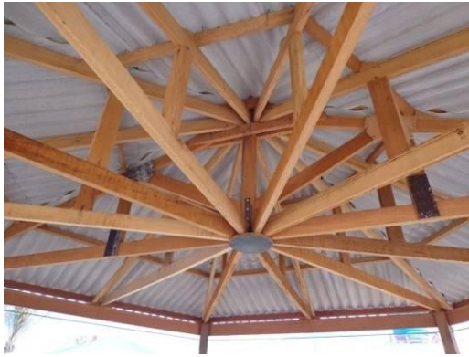
Figura – 12.2. 7 - Construção de estruturas a partir do produto florestal, proveniente da atividade de supressão vegetal, coordenada UTM Zona 22 M 395183; 9619496
