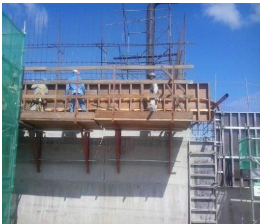
Figura - 12.2. 11 - Construção de estruturas a partir do produto florestal, proveniente da atividade de supressão vegetal, coordenada UTM Zona 22 M 395870 / 9619662
