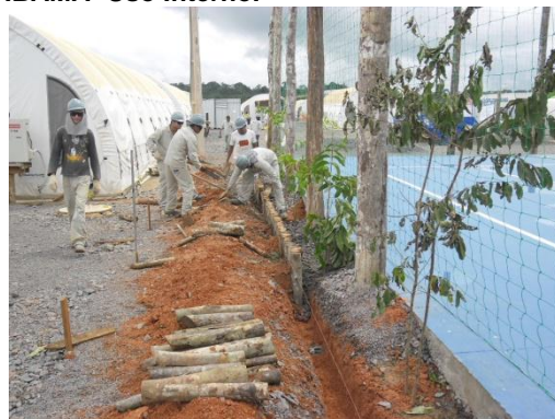
Figura – 12.2. 15 – Humanização de canteiro.
