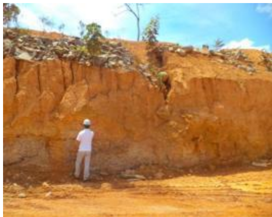
Figura 10.4 - 15 – Vista geral do talude de corte do Ponto 12
