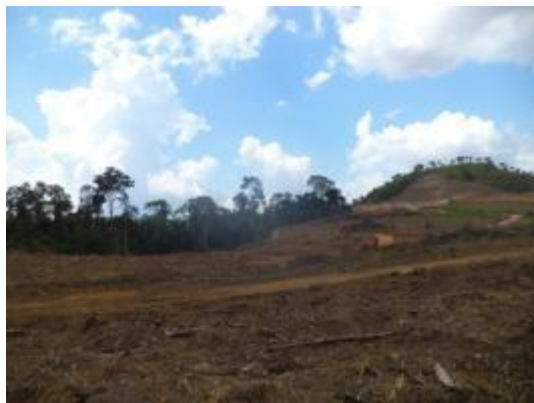
Figura 10.4 - 29 – Vista geral da área desmatada para construção do dique 8A do Ponto 21
