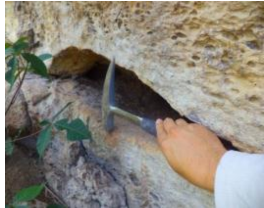
Figura 10.4 - 20 – Detalhe da cavidade da foto anterior
