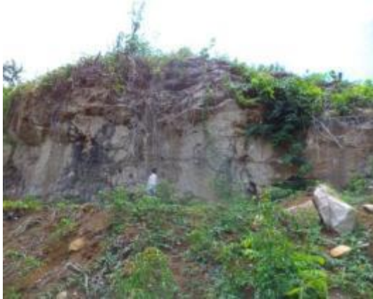
Figura 10.4 - 17 – Vista geral do paredão rochoso de arenito do Ponto 14
