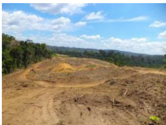
Figura 10.4 - 27 – Vista geral da área desmatada para construção do dique 8B do Ponto 18
