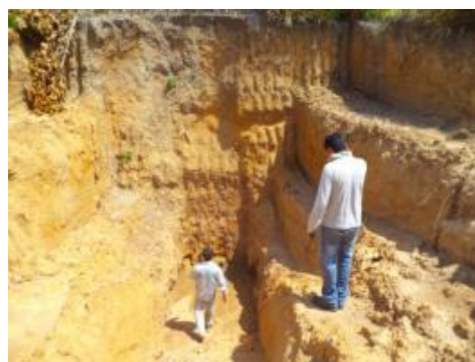
Figura 10.4 - 28 – Talude de corte para construção do dique 8B do Ponto 19. Exposição de material terroso
