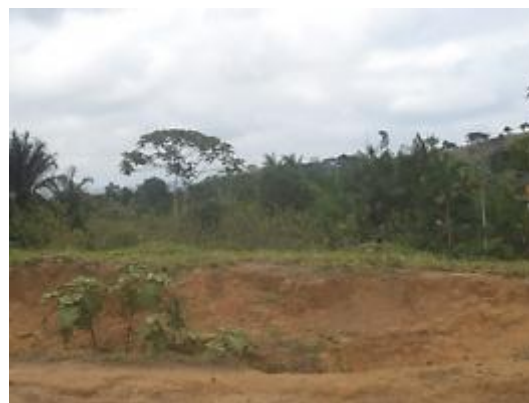
Figura 10.4 - 10 – Pequeno talude de corte caracterizado por solo arenoso, oriundo de arenito da Formação Maecuru (Ponto 4)
