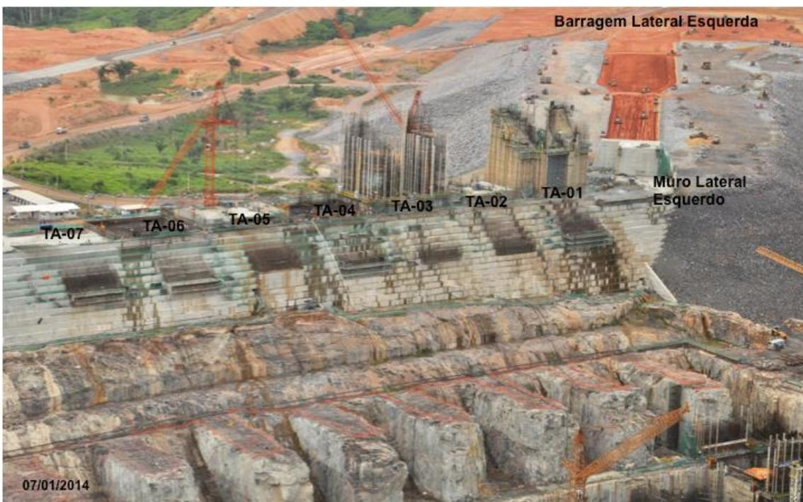
**Figura 2 - 6 – Vista de jusante dos blocos 01 a 07 da Tomada de Água Principal, podendo ser observados o Muro Lateral Esquerdo e a Barragem de Fechamento Esquerda**
