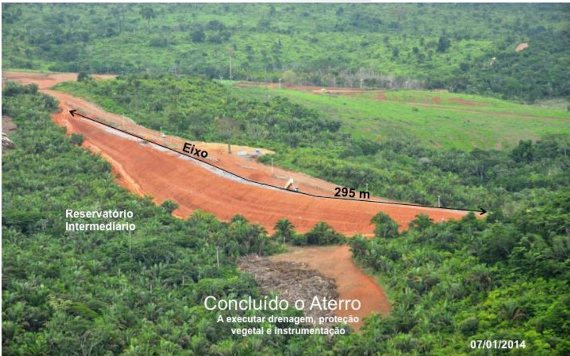
Figura 2 – 22 – Vista geral da área do Reservatório Intermediário e do Dique 19C, em execução
