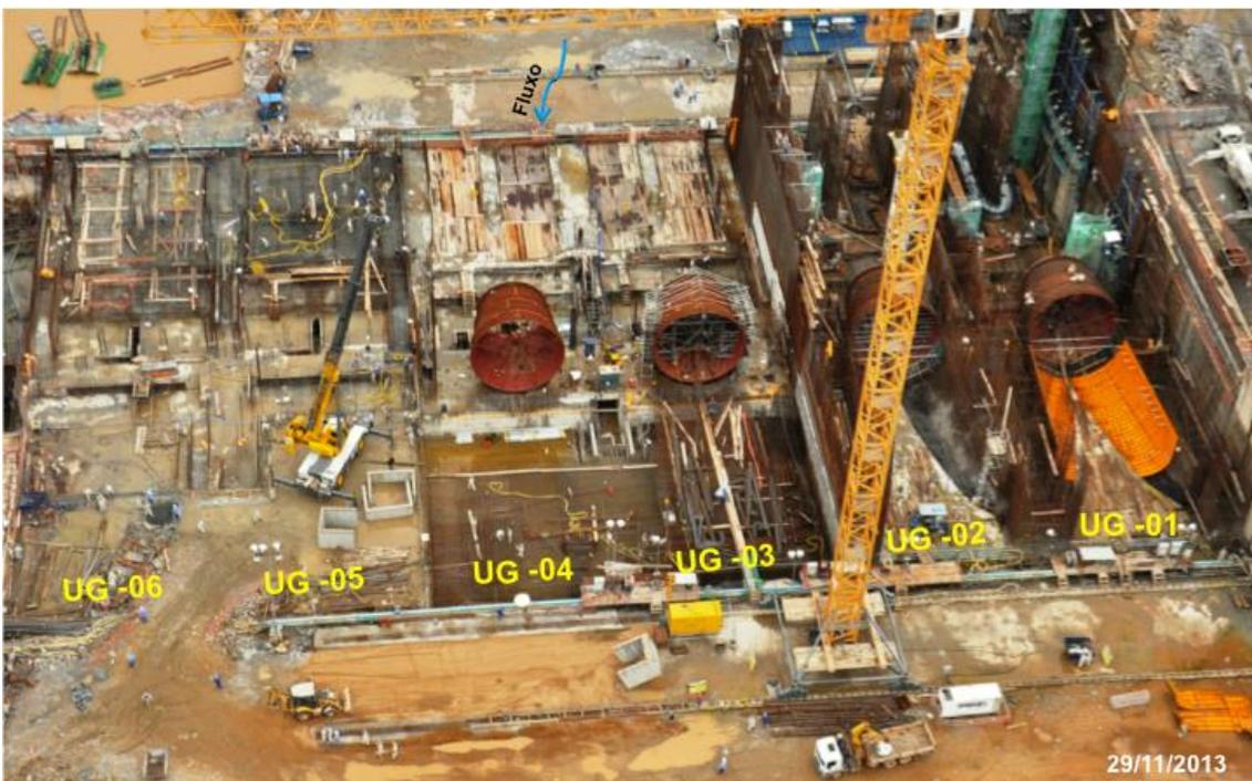
Figura 2 – 12 – Serviços de concretagem e montagem na área da Tomada de Água e Casa de Força Auxiliares
