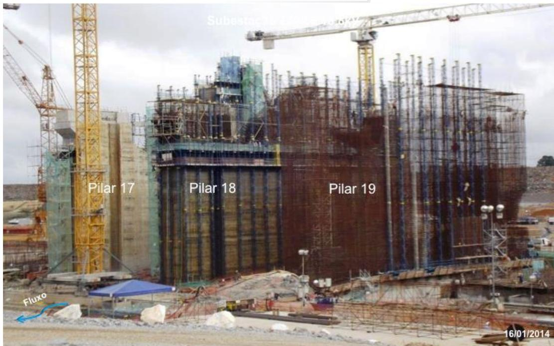
Figura 2 – 13 – Execução dos pilares do Vertedouro
