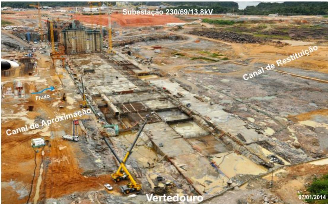
Figura 2 – 11 – Vista geral da área de fundação da Tomada de Água e Casa de Força Auxiliares. Ao fundo, aterro da Subestação, em construção
