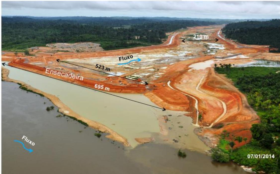
Figura 2 – 15 – Vista geral da área do emboque do Canal de Derivação (km 00)
