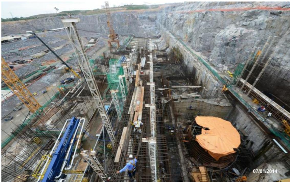
**Figura 2 – 26 – Serviços de montagem do cotovelo do Tubo de Sucção da Unidade Geradora (UG) 01, no Sítio Belo Monte**
