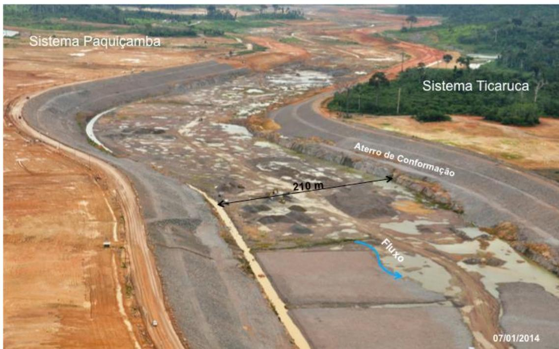
Figura 2 – 18 – Proteção de taludes e do fundo do Canal de Derivação (km 13 a 15)
