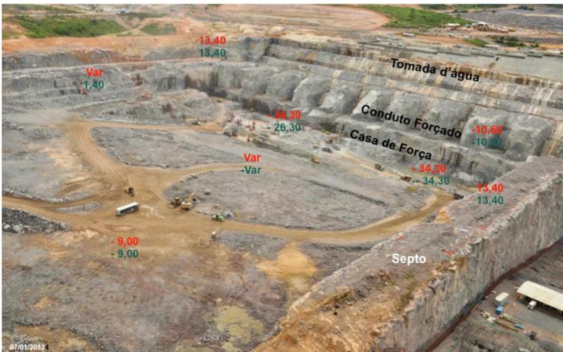
Figura 2 – 4 – Vista geral da escavação em rocha para os blocos 09 a 18 do Sistema Gerador
