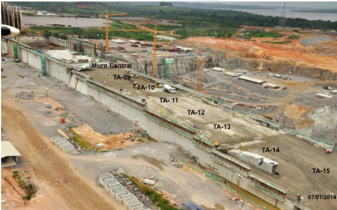
**Figura 2 – 5 – Vista geral das estruturas de concreto – Muro Central e Tomada de Água – com os maciços de Concreto Compactado a Rolo em execução**
