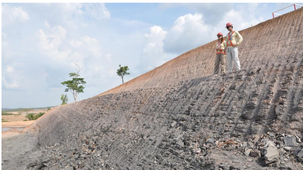
Figura 8 - Talude de rocha do ponto C2P4, descrito na coluna 4.
