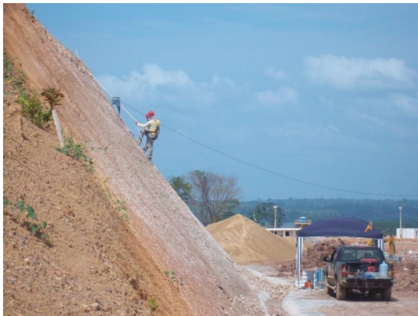
Figura 10 - Talude de rocha do ponto C3P2, descrito na coluna 2.
