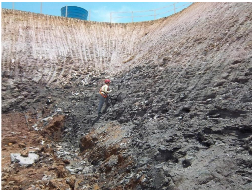
Figura 6 - Talude de rocha do ponto C2P2, descrito na coluna 2.
