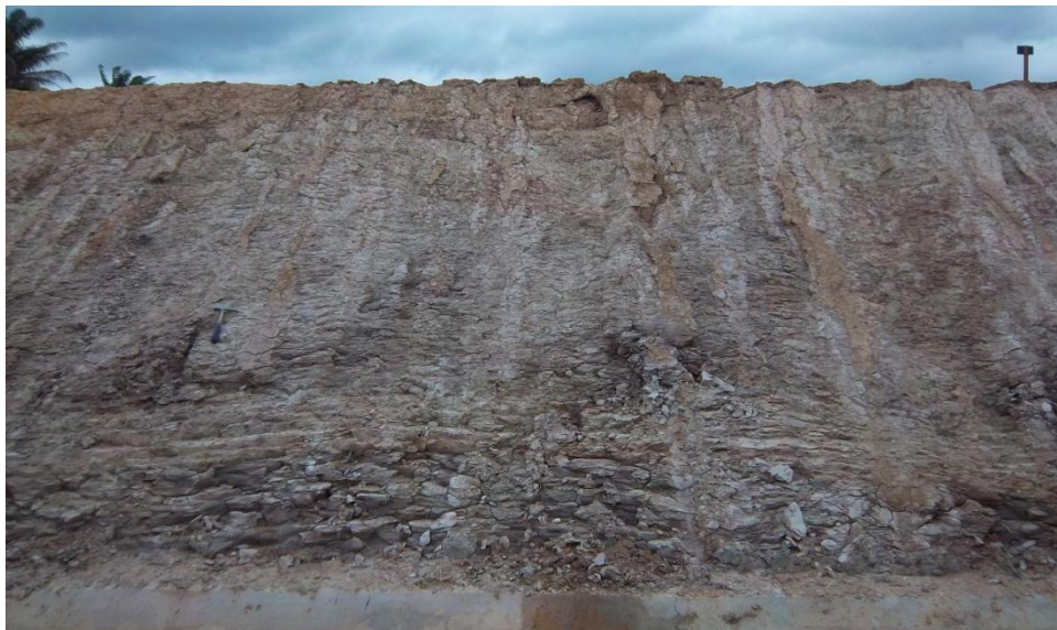
Figura 5 - Talude de rocha do ponto C2P1, descrito na coluna 1.
