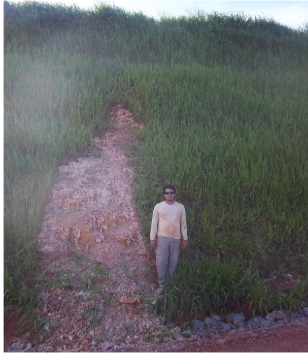
Figura 19 - Corte na margem oeste do Travessão 27.
