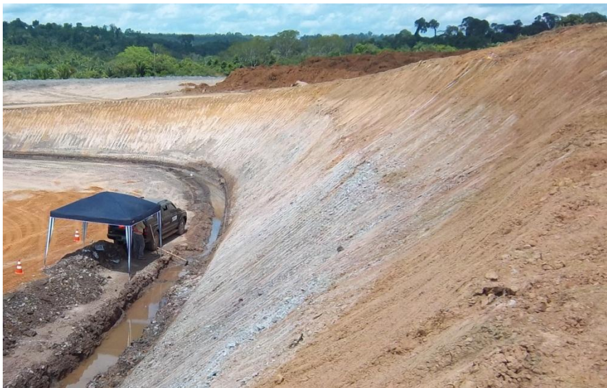
Figura 2 Talude de rocha do ponto C1P3, descrito na coluna 2.
