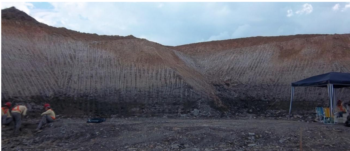
Figura 7 - Talude de rocha do ponto C2P3, descrito na coluna 3.
