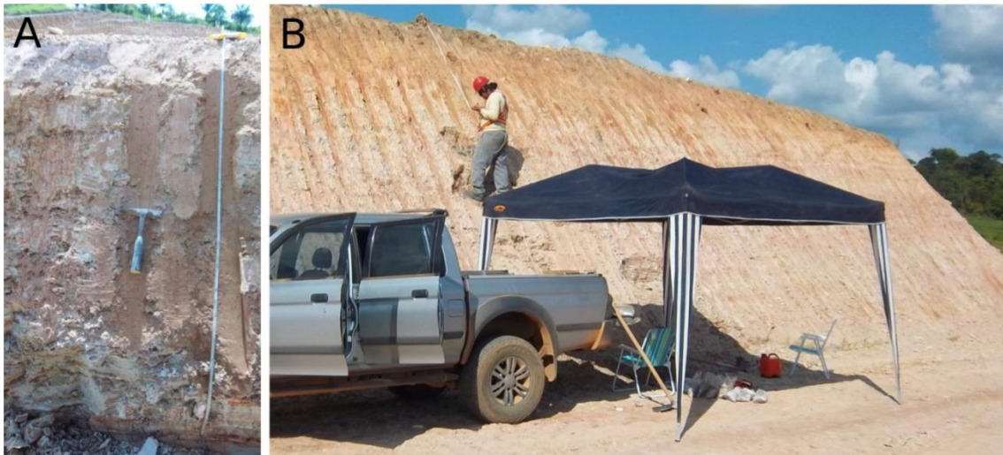
Figura 3 - Talude de rocha dos pontos C1P4 (A; base) e C1P5 (B; topo), descritos na coluna 3.
