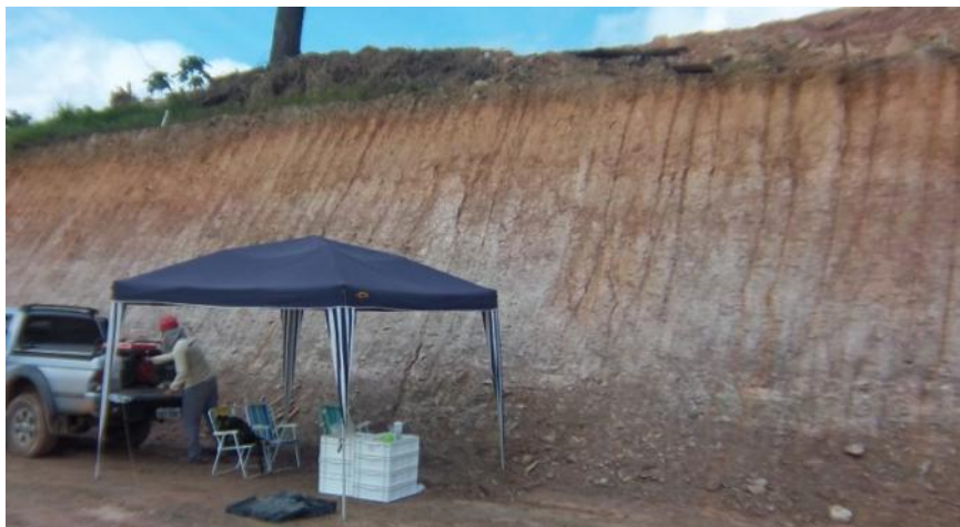
Figura 3 - Corte adjacente a área plana construída por terraplenagem, ponto C5P3 (TERRAGRAPH, 2012).
