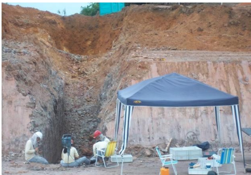
Figura 4 - Lateral norte do reservatório leste de água, ponto C5P4 (TERRAGRAPH, 2012).
