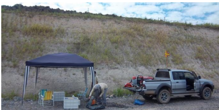
Figura 2 - Corte no acesso 52A, ponto C5P2 (TERRAGRAPH, 2012).
