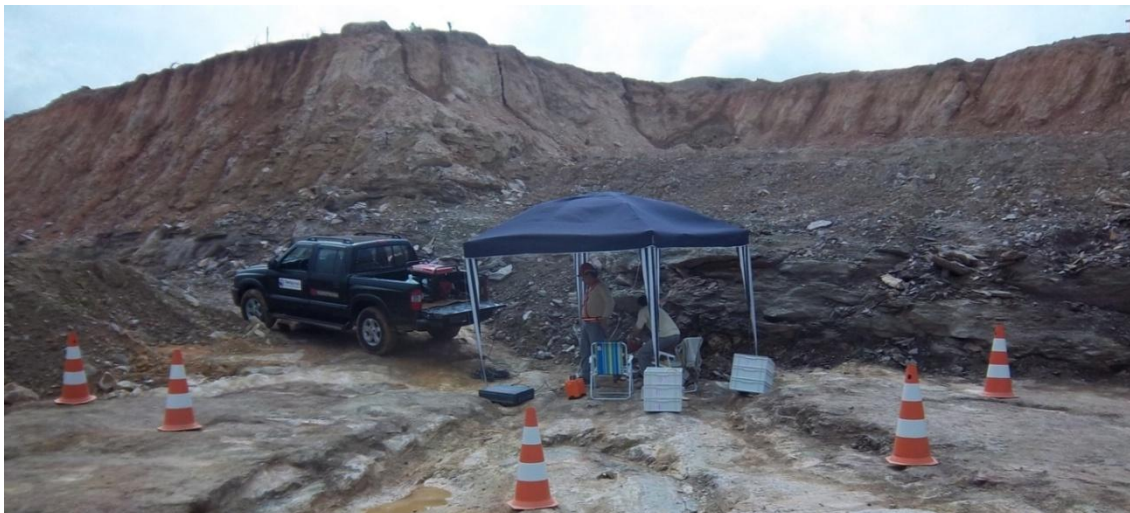
Figura 9 - Talude de rocha do ponto C3P1, descrito na coluna 1.
