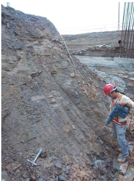
Figura 11 - Talude de rocha do ponto C3P3, descrito na coluna 3.
