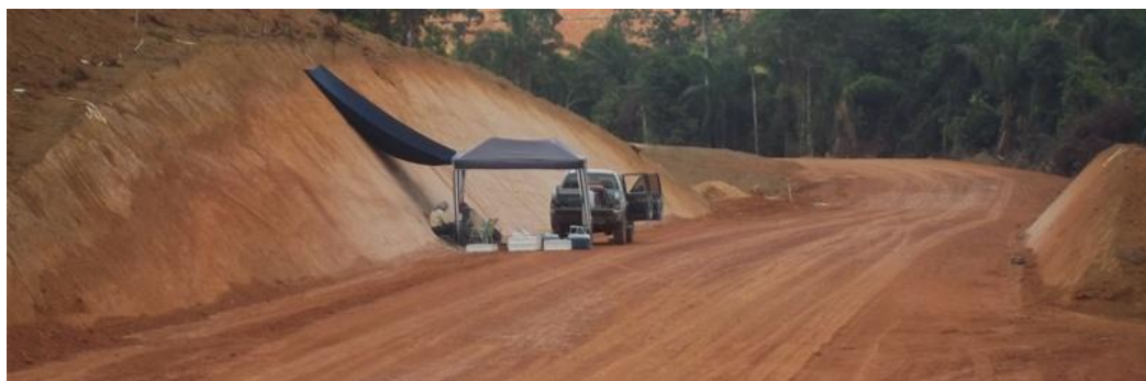
Figura 10 - Coluna 2 (ponto C6P5), em corte de estrada, Sítio Belo Monte (TERRAGRAPH, 2012).
