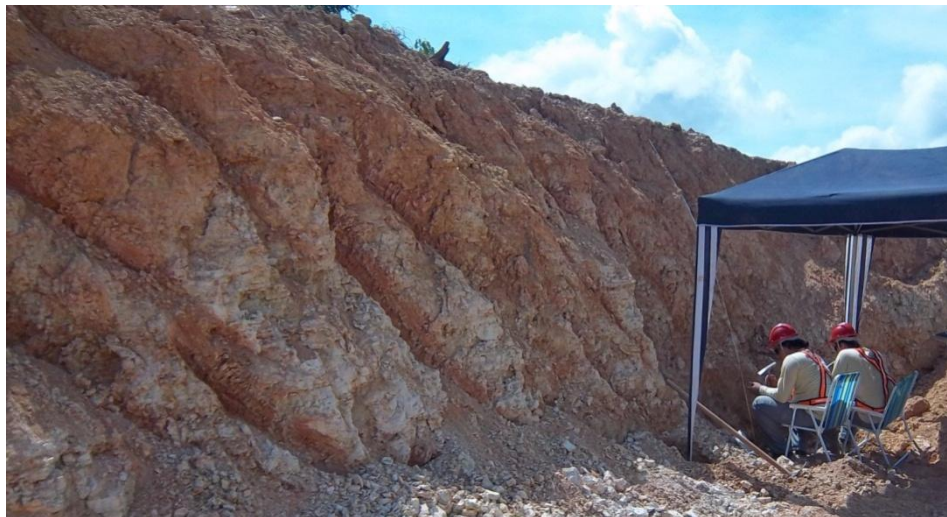
Figura 4 - Talude de rocha do ponto C1P6, descrito na coluna 4.
