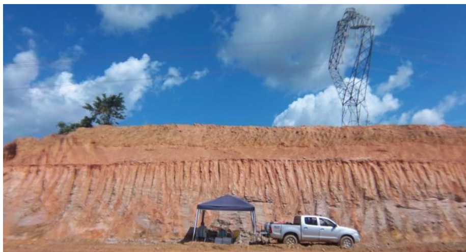
Figura 7 - Conjunto espesso de rochas sedimentares abaixo da rede de alta tensão a ser desativada, próximo à ensecadeira, ponto C5P6 (TERRAGRAPH, 2012).
