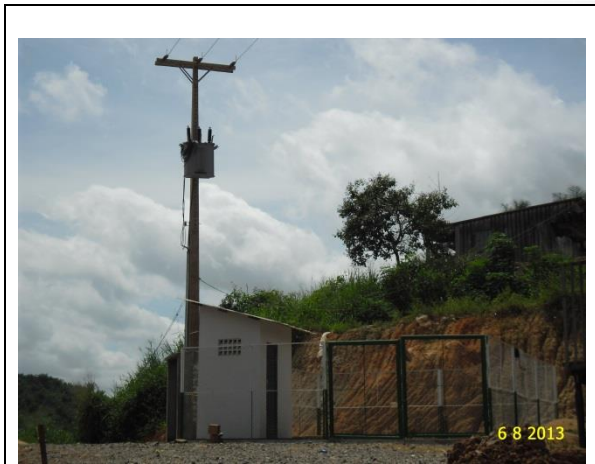
Figura 07 – Estação elevatória de esgoto 01 instalada em Belo Monte.
