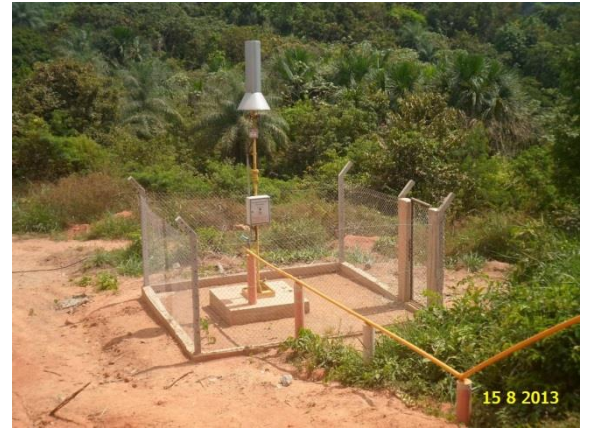
Figura 08 – Queimador de Biogás da Estação de tratamento de Belo Monte.
