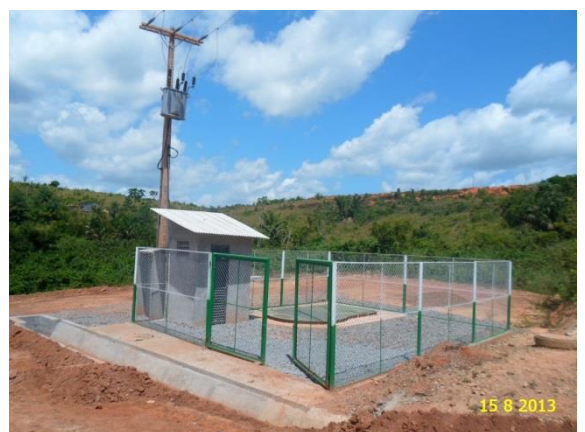
Figura 06 – Estação elevatória de esgoto 02 instalada, em Belo Monte.
