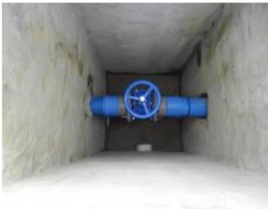
**Figura 5.2.19 - 1 – Instalação de Registro no reservatório apoiado do SAA**
