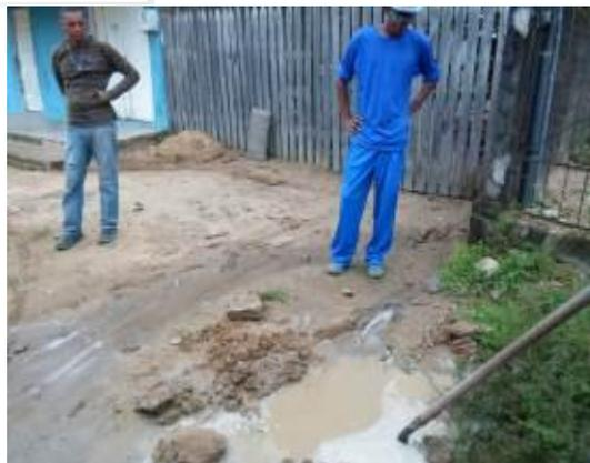
**Figura 5.2.19 - 2 – Observação do teste de pressão na rede de distribuição.**
