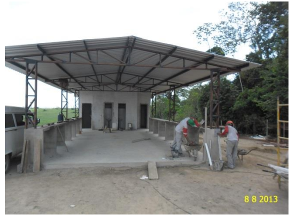
Figura - 6 – Galpão de triagem em finalização
