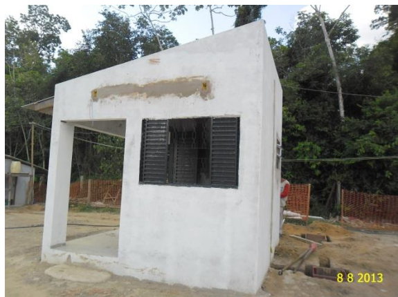
Figura - 5 – Guarita em finalização
