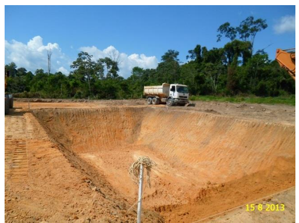
Figura - 4 – Escavação para implantação da estação de tratamento de lixiviado.
