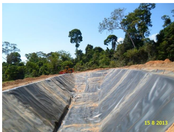
Figura - 3 – Célula 03 impermeabilizada com geomembrana de PEAD.
