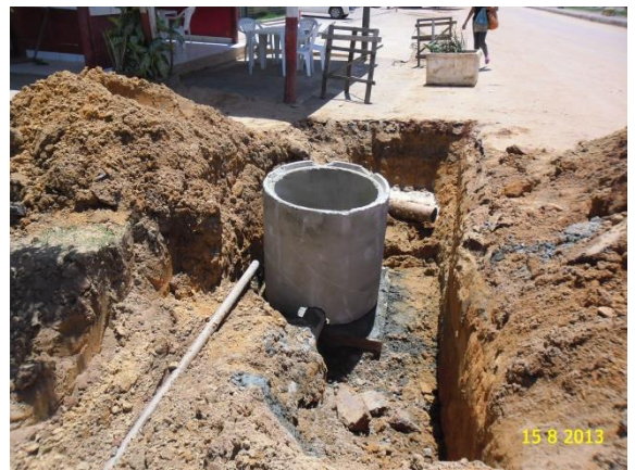
Figura - 2 – Construção de poço de visita da rede coletora de esgoto.
