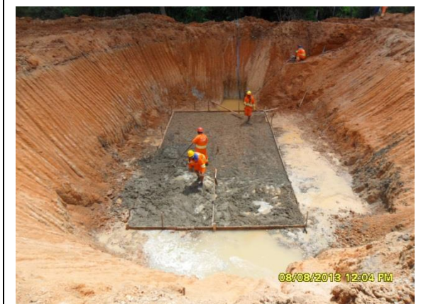
Figura - 5 – Execução da ETE.
