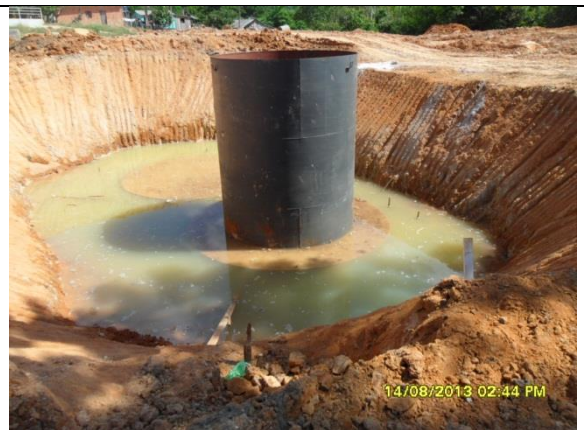
Figura - 6 – Início da instalação do reator da ETE A.
