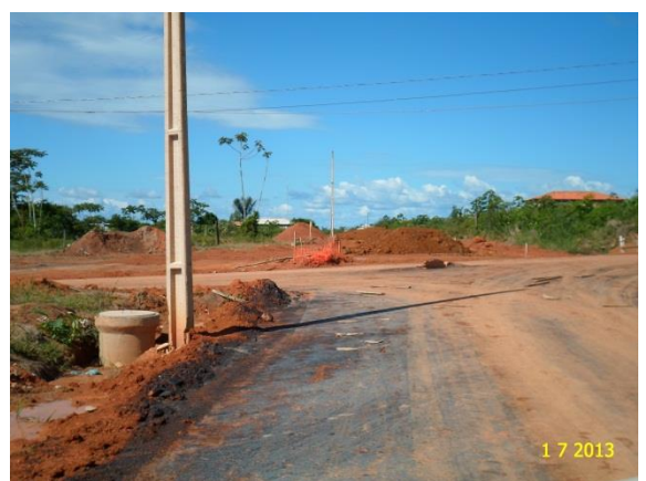
Figura - 4 – PV e tampa em concreto armado finalizados
