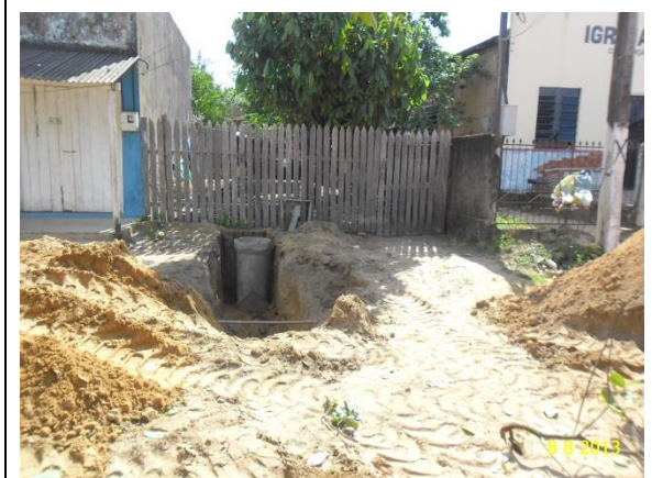
Figura - 3 – Instalação dos ramais de ligação domiciliar com as caixas de inspeção.
