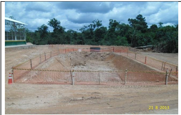
Figura - 7 – Início da escavação para implantação do sistema de tratamento de esgoto – ETE A
