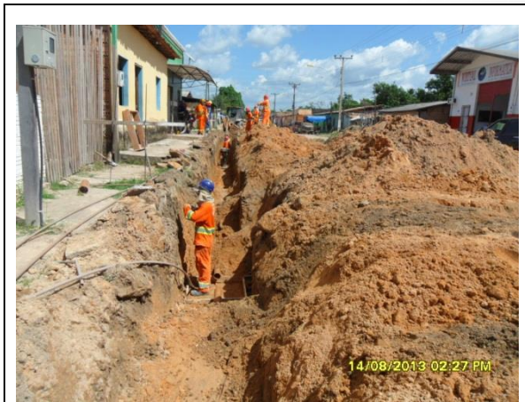
Figura - 1 – Escavação de vala com assentamento da rede coletora de esgoto.
