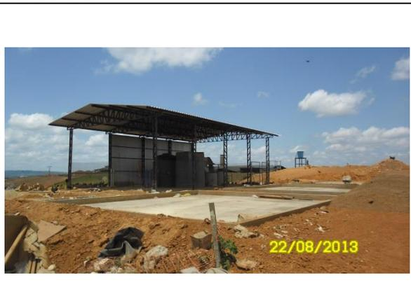
**Figura - 6 – Estação de lixiviado e leito de secagem de lodo.**
