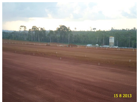
Figura - 6 – Execução de terraplenagem com preparação de base (RUC Jatobá).
