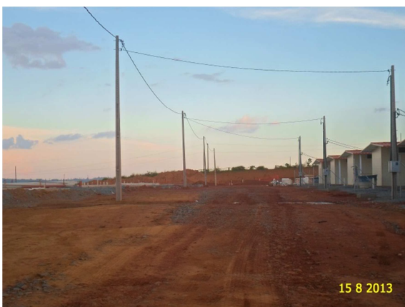
Figura - 5 – Instalação da rede de distribuição de energia (RUC Jatobá).
