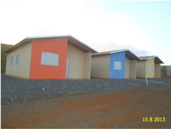
Figura - 1 – Construção das casas modelo para visitação da comunidade (RUC Jatobá).
