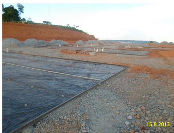
Figura - 11 – Execução de radier para construção das casas (RUC São Joaquim)
