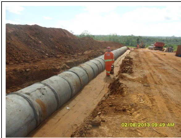
Figura - 7 – Execução de terraplenagem com preparação de base (RUC Jatobá).
