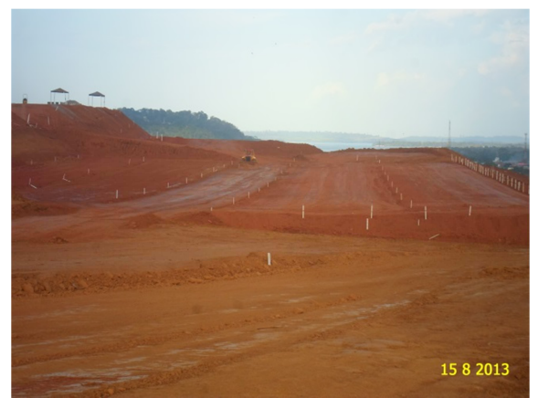
Figura - 10 – Execução de terraplenagem e demarcação de lotes (RUC São Joaquim).
