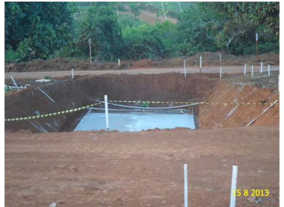
Figura - 4 – Construção da ETE provisória (RUC Jatobá).
