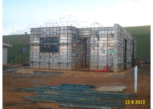
Figura - 2 – Montagem das formas para construção das casas (RUC Jatobá).
