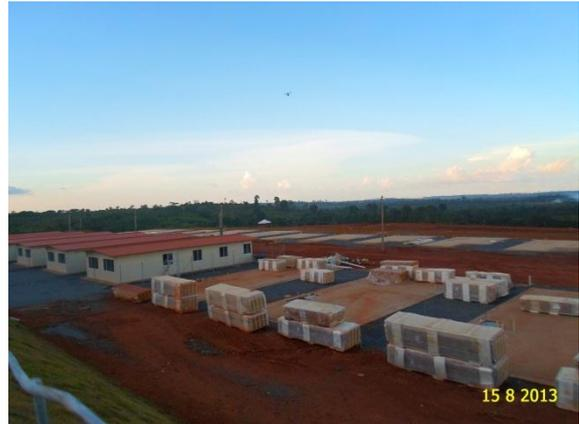
**Figura - 2 - Unidades construídas, radier's prontos e acessórios de montagem dos painéis das casas.**
