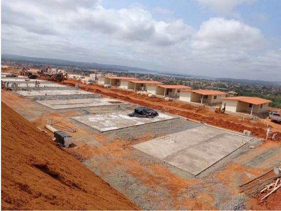
**Figura - 6 – Unidades construídas e radiers prontos no reassentamento São Joaquim.**
