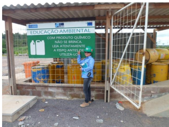
Figura - 5 – Sinalização orientativa para manuseio de produtos químicos
