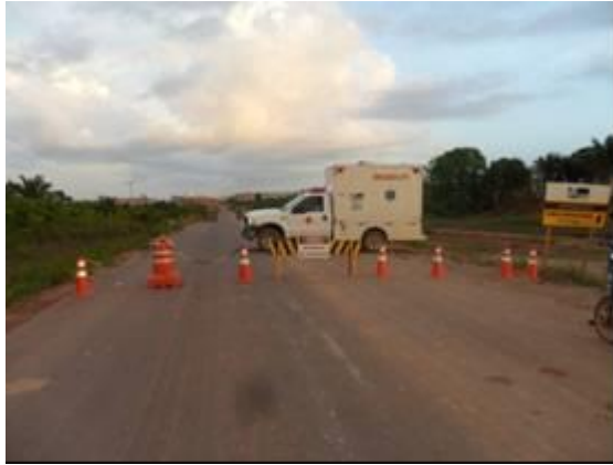
Figura - 7 – Isolamento de área para detonação
