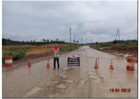
Figura - 8 – Isolamento de área para detonação
