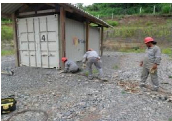
Figura - 5 – Implementação de aterramento nos containers de armazenamento de explosivos
