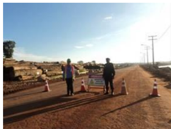
Figura - 6 – Isolamento de área para detonação
