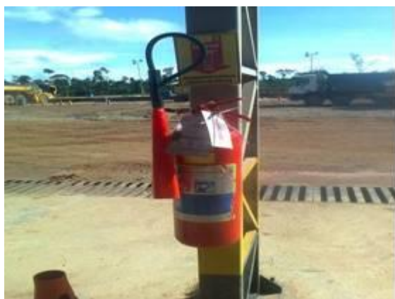
Figura - 5 – Equipamento de combate a incêndio
