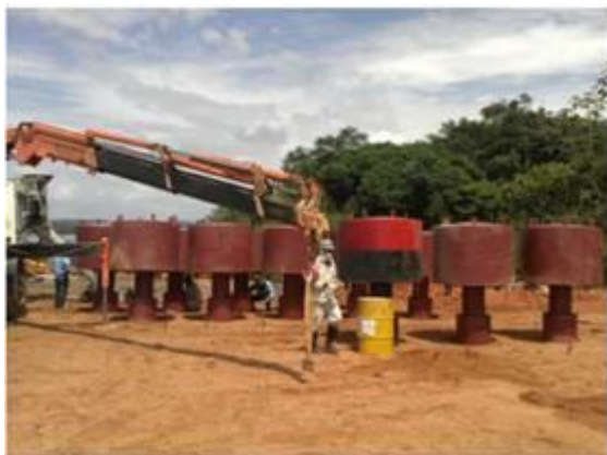
Figura - 7 – Posicionamento, travamento e concretagem das bóias
