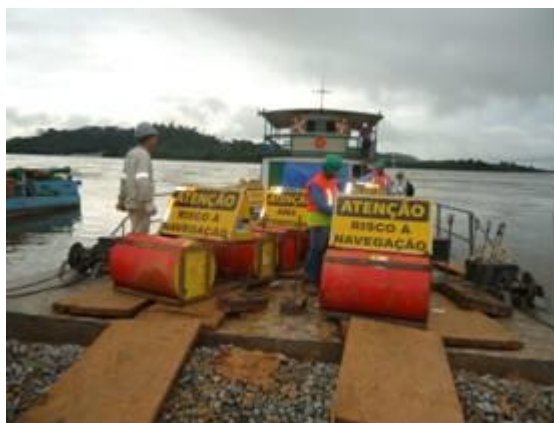
Figura - 6 – Sinalização provisória – Sítio Pimental
