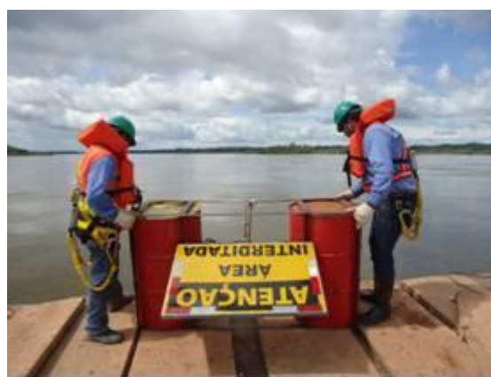
Figura - 4 – Sinalização provisória – Sítio Pimental
