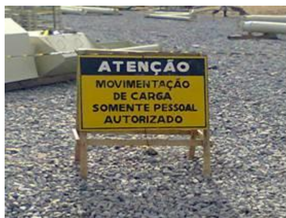
Figura - 6 - Sinalização alertando para risco na atividade
