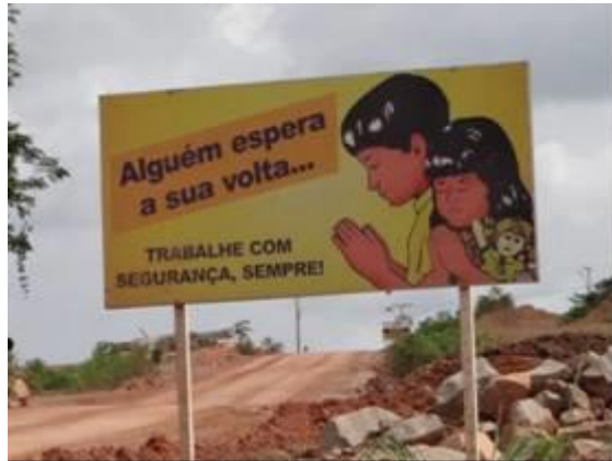
Figura - 15 – Sinalização de sensibilização
