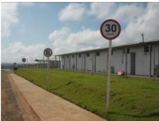
Figura - 9 – Sinalização orientativa nos acessos internos dos canteiros
