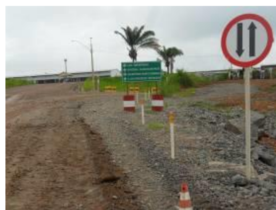
Figura - 6 – Sinalização orientativa nos acessos internos dos canteiros
