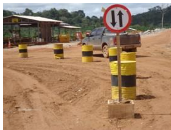
Figura - 12 – Sinalização orientativa nos acessos internos dos canteiros
