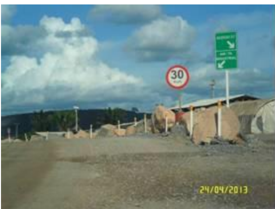
Figura - 11 – Sinalização orientativa nos acessos internos dos canteiros
