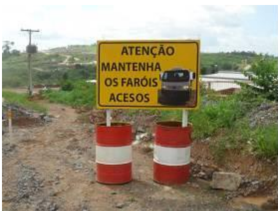
Figura - 5 – Sinalização orientativa nos acessos internos dos canteiros
