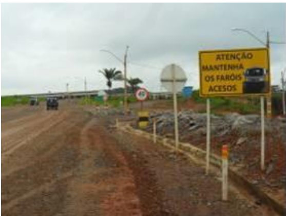
Figura - 7 – Sinalização orientativa nos acessos internos dos canteiros
