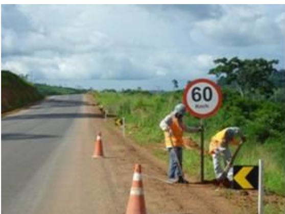
**Figura - 5 – Instalação de placa de limite de velocidade – Travessão 27**
