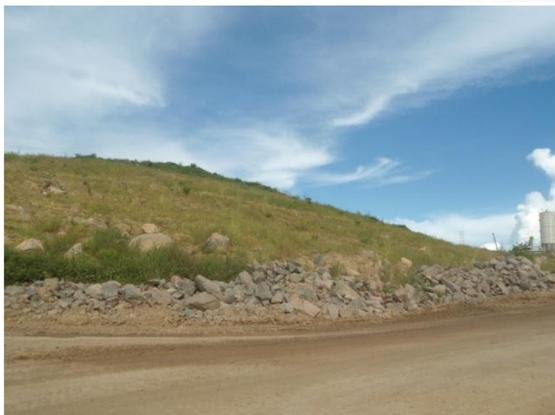
**Figura 3.2 – 11 – BF3: talude após lançamento do solo vegetal e crescimento da vegetação.**
