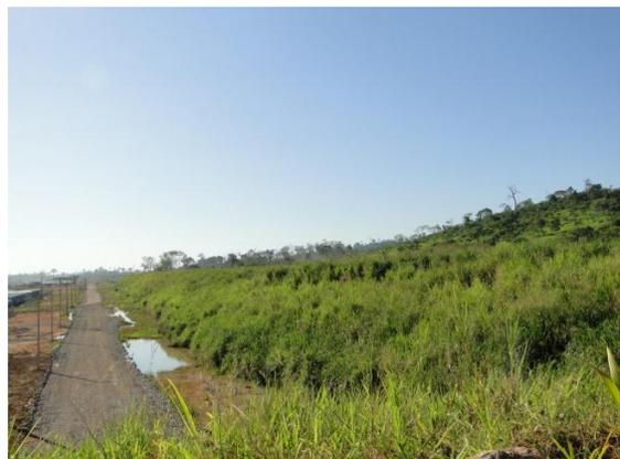
**Figura 3.2 – 10 – BF-37 do Canal de Derivação: talude reconformado e revegetado.**
