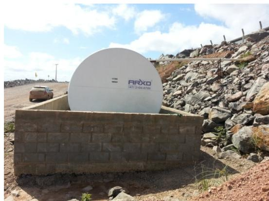
Figura - 2 – Depósito de óleo lubrificante usado
