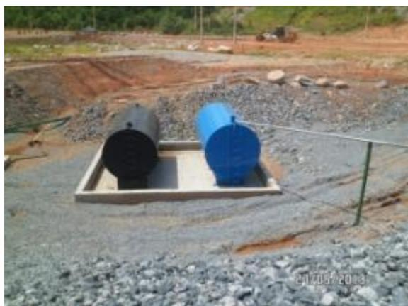
Figura - 6 – Depósito de óleo lubrificante usado
