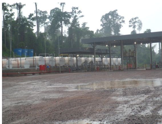
Figura - 4 – Plant definitivo em processo de instalação – Sítio Canais
