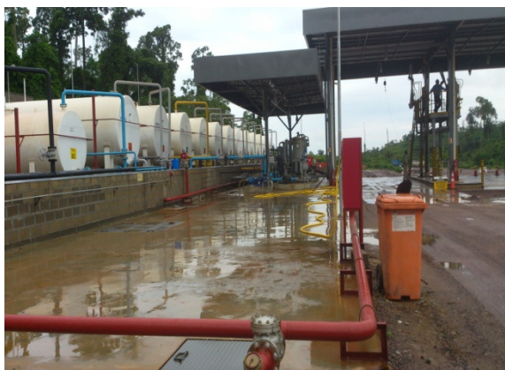
Figura - 5 – Plant definitivo em processo de instalação – Sítio Canais
