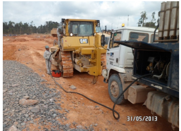
Figura - 10 – Abastecimento dos equipamentos em campo
