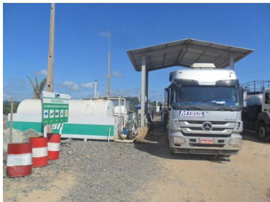
Figura - 1 – Plant provisório – Sítio Belo Monte
