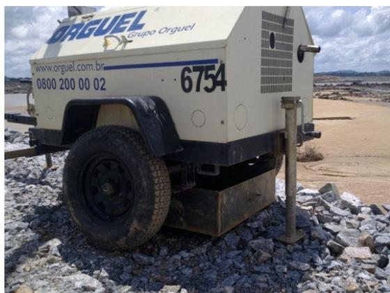
**Figura - 15 – Instalação de bandejas nas torres de iluminação**
