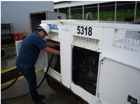
**Figura - 13 – Limpeza e manutenção dos geradores**
