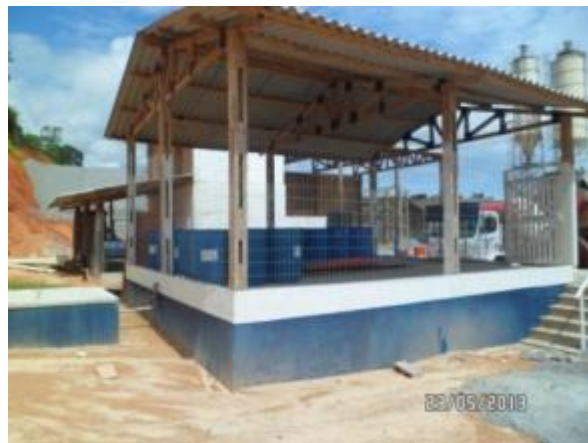
Figura - 8 - Depósito de produtos químicos da Central de Concreto
