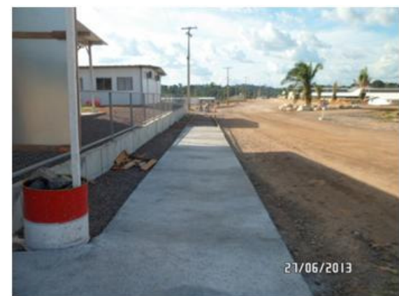
Figura - 12 – Construção de calçadas nos escritórios
