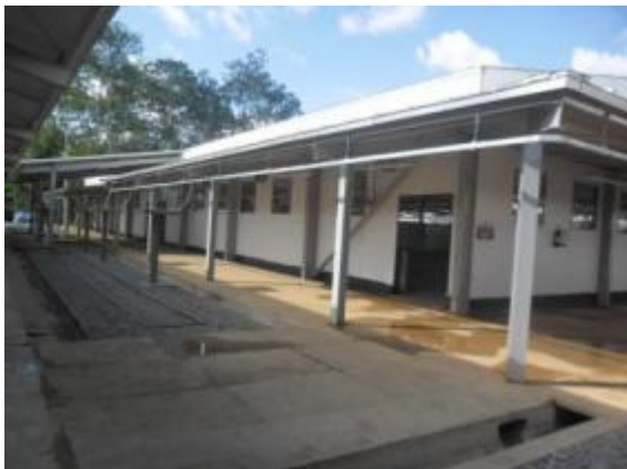
Figura - 1 – Estrutura externa do refeitório definitivo de Pimental
