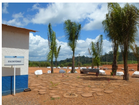
Figura - 5 – Urbanização na Central de Triagem de Resíduos Sólidos de Belo Monte
