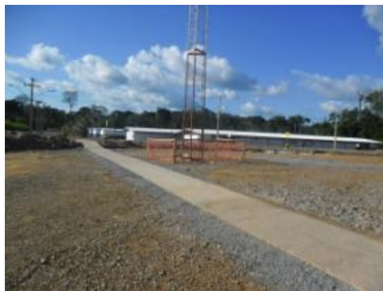
Figura - 16 – Passarelas para pedestres no canteiro
