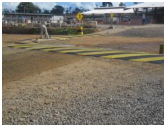
Figura - 18 – Implantação de quebra molas no canteiro pioneiro de Pimental
