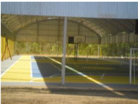
Figura - 15 – Finalização da quadra poliesportiva no canteiro de Pimental
