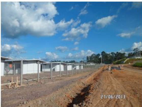
Figura - 13 – Instalação de canaletas na área de alojamento
