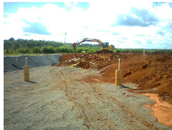
Figura - 16 – Vala do aterro sanitário em operação
