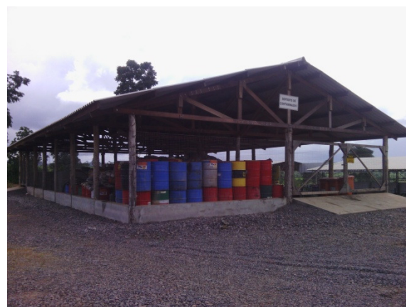
Figura - 10 – Depósito de resíduos perigosos
